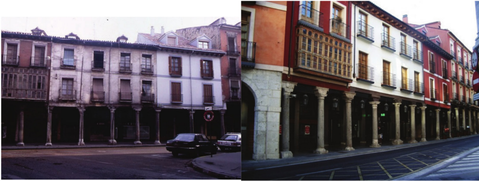
Figura 5. Valladolid. Calle Cebadería, hacia 1985 y su estado actual
