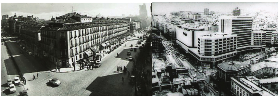
Figura 1. Madrid, Barrio de Pozas, antes y después de su demolición
