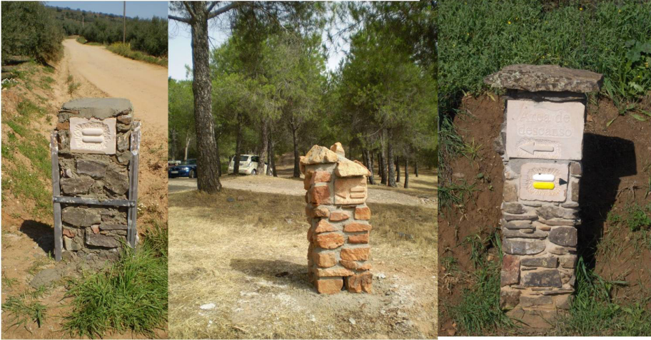
Figura 8. Construcción de hitos de señalización
