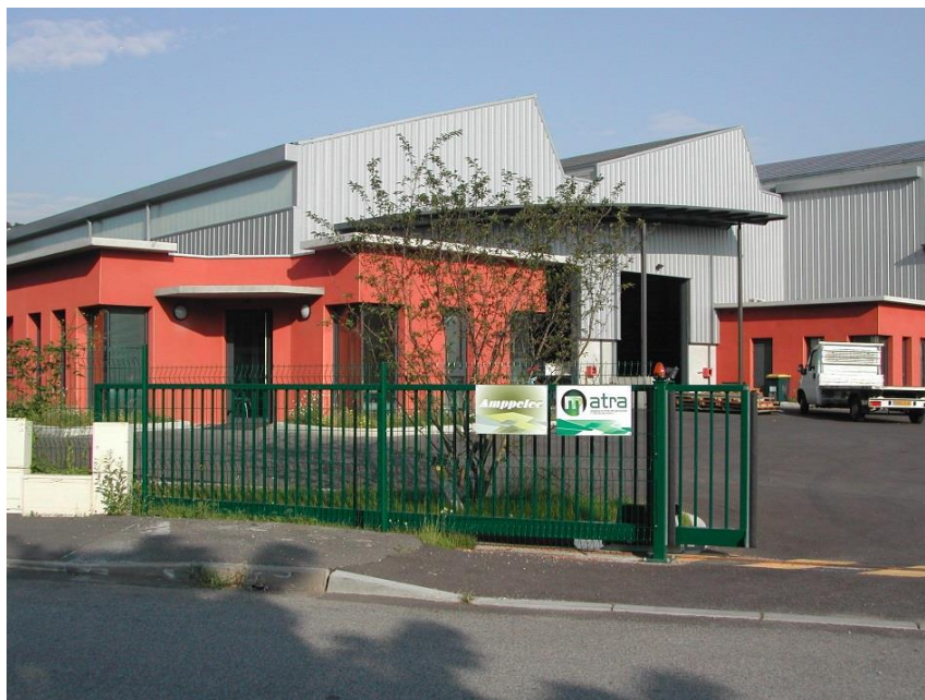
Figure 1. Entrée principale de l'usine
