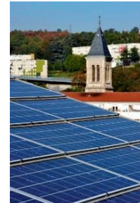
Figure 6. Panneaux solaires sur le toit de l'usine
