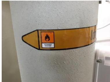
Imagen 70. Advertencia de materiales inflamables en el depósito de hidrógeno.
