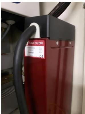
Imagen 22. Banco de condensadores para la corrección del factor de potencia.
