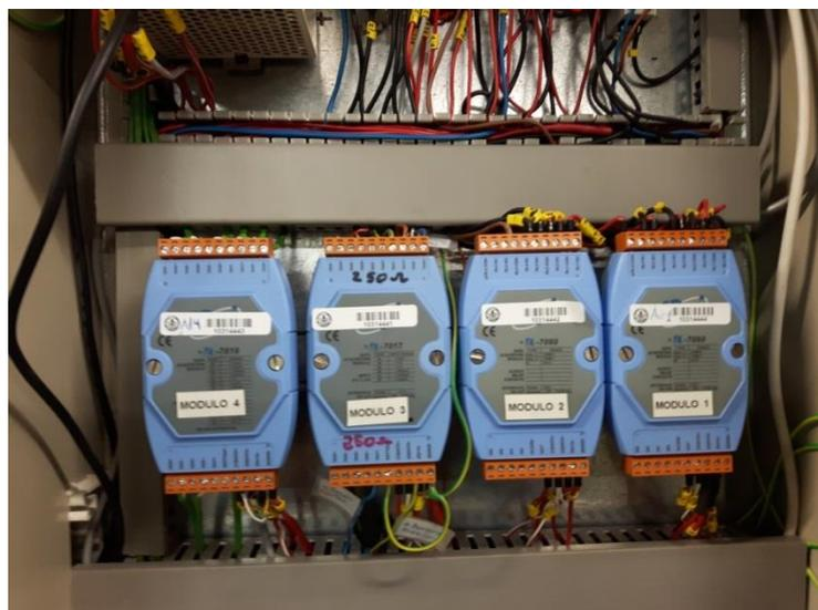
Imagen 39. Módulos de entradas y salidas en la red RS285.
