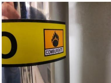
Imagen 71. Advertencia de materiales comburentes en el depósito de oxígeno.
