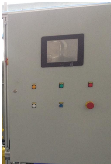
Imagen 8. Cuadro de control de la planta.
