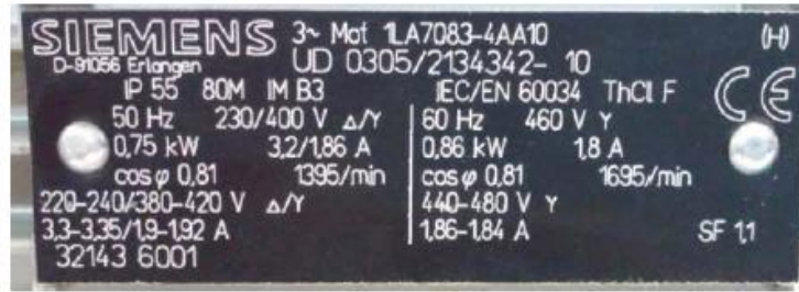
Figura 3.11 Placa de las características del motor de inducción.
