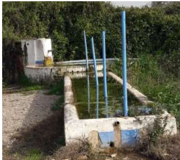
Ilustración 22: Fuente del "Rey" proporciona agua al aljibe, y pilón.
