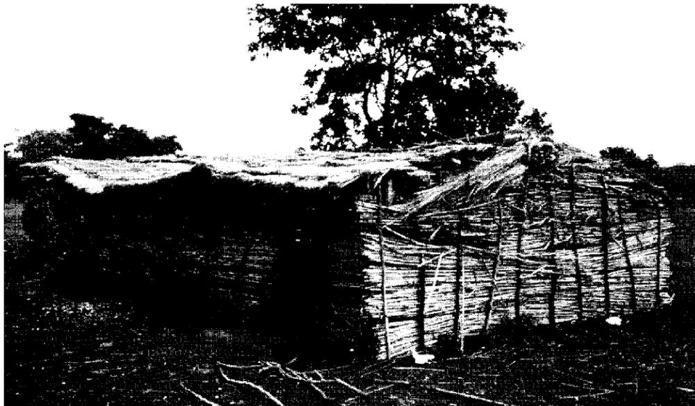
**Figura 49:** Hábitat nómada con cubierta plana de paja. **Fuente:** Architecture et culture constructive du Burkina Faso. (Kere, 1995)
