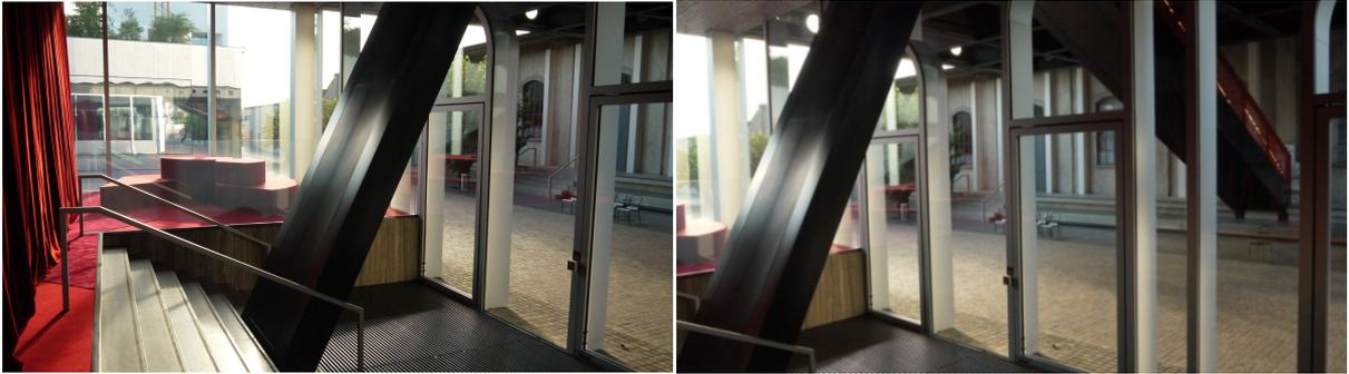
**62 y 63** Entrada a la planta inferior del **Podio**, desde la que se puede observar la estructura oblicua que sustenta la planta superior. Al mismo tiempo podemos observar las escaleras de subida a la parte superior del Podio y su obvio paralelismo con la estructura.
