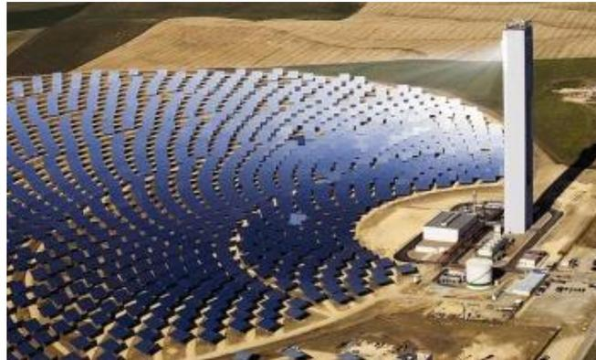
Ilustración ( 4.9 ): Central de energía solar térmica. Fuente: google images.
