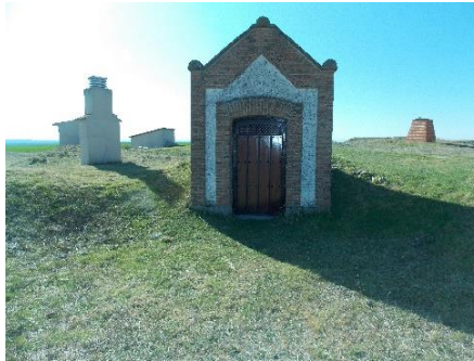
7. Frente de acceso a bodega nº 5.
