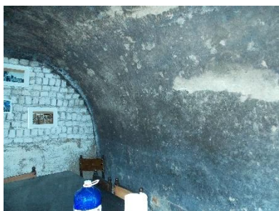
15. Bodega nº 9 hueco lateral.
