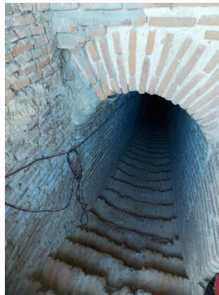
17. Bodega nº 10 cañón de acceso.
