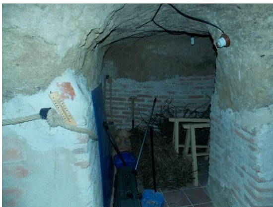
4. Nicho lateral con la función de almacén, lo encontramos en la bodega nº 4.
