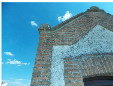
7. Bodega nº 5 detalles en la entrada.
