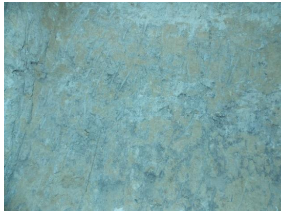
1. Marcas del pico durante la excavación.
