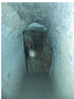
19. Bodega nº 11 puerta original.
