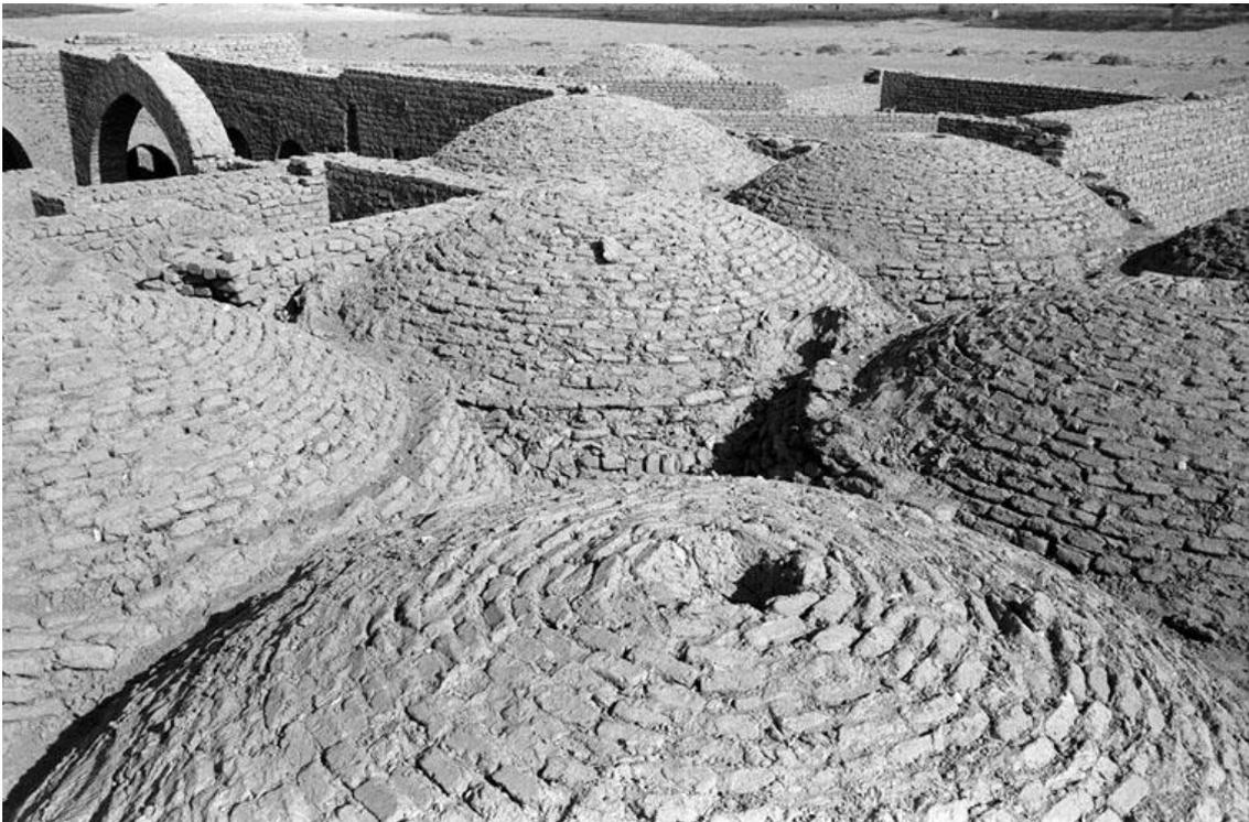
**Figura 43: Cúpulas en Nueva Baris en construcción.**
