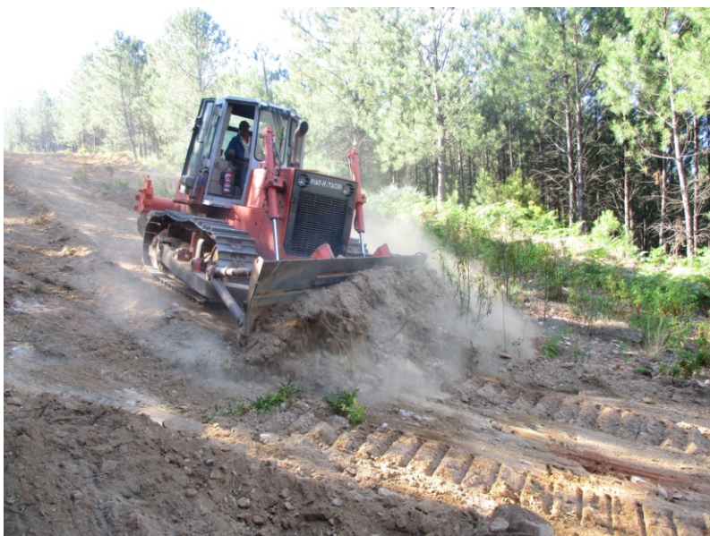
Imagen 34: Bulldozer realizando el repaso de la red de cortafuegos de la comarca de Arenas de San Pedro. (Fuente: Elaboración propia).
