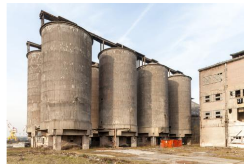
Img 70-71: vistas exteriores.
