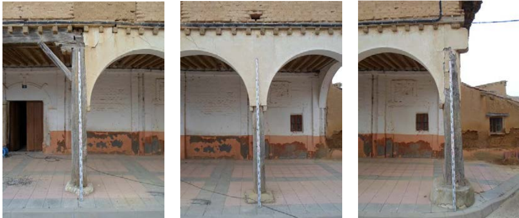
Figura 3. Casa-Hospital de la Vera Cruz de San Juan, Villalón de Campos, España. Columnas de madera del soportal del Hospital, estudio métrico y constructivo (GrupoTIERRA, 2015)
