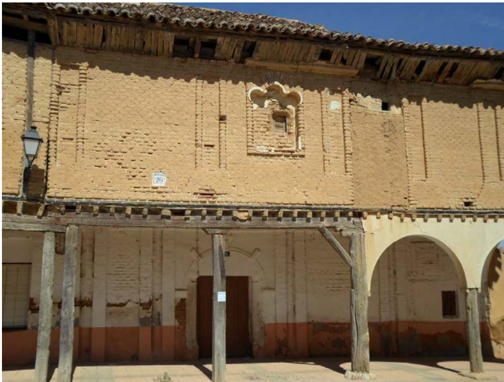
Figura 1. Casa-Hospital de la Vera Cruz de San Juan, Villalón de Campos, España. Fachada principal a la plaza de San Juan
