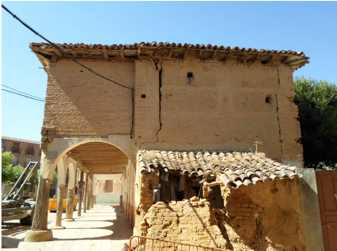
Figura 5. Casa-Hospital de la Vera Cruz de San Juan, Villalón de Campos, España. Fachada lateral a la calle Hospital
