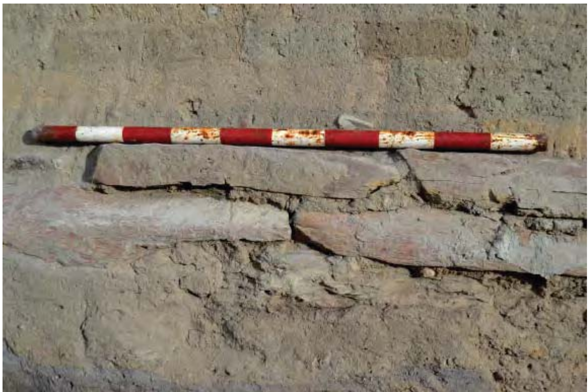
41) Fig. 20. Arriba detalle del basamento de lascas de pizarras y cuarcitas. Abajo solado de hormigón armado.. (Blanco 2014:
