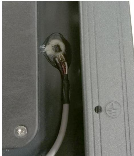
Figura 67. Montaje del sensor LM35.
