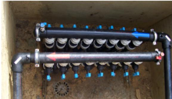
**Figura 4. 2. Colector geotérmico**
