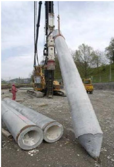
**Figura 1.22.Pilote prefabricado**
