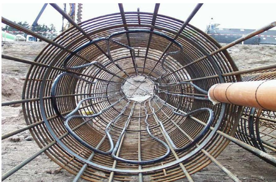
Figura 1.21. Pilotes de hormigón armado de sección completa
