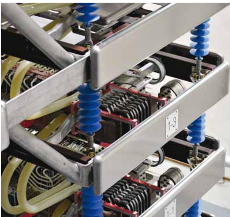
Fig.2.3 Válvula de tiristores.
