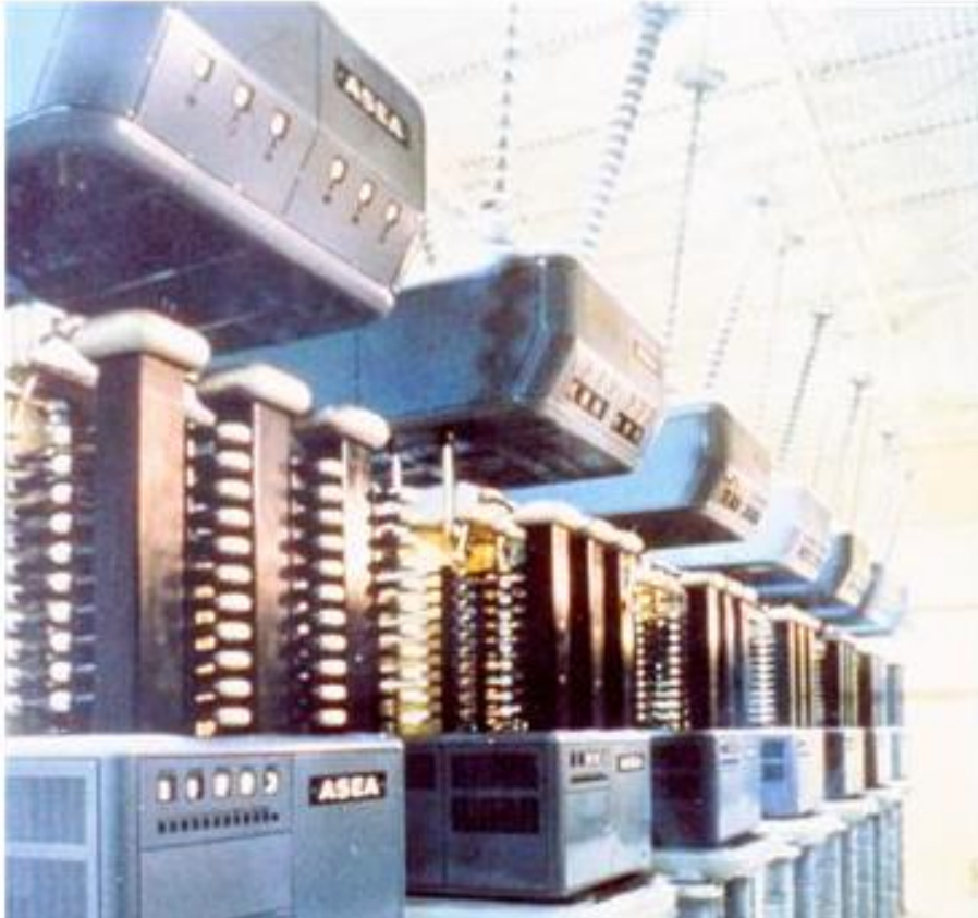
Fig.2.6 Sala de válvulas de arco de mercurio (estación de Sylmar).
