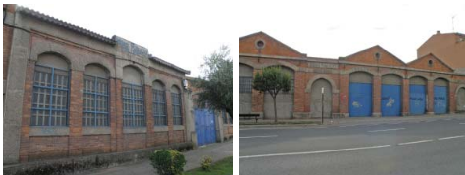
Fig. 10. Talleres-Cocheras de Obras Públicas (Carretera de La Fregeneda)
