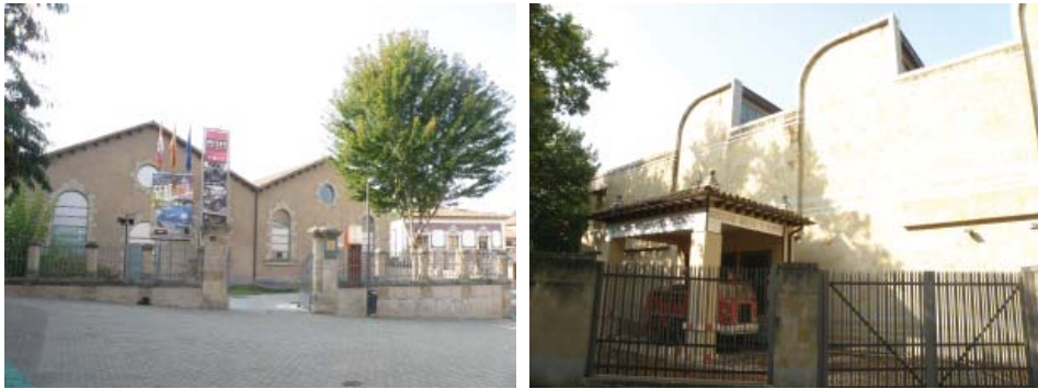
Fig. 11. Antigua fábrica de electricidad La Unión Salmantina, hoy Museo de Automoción. En la imagen izquierda, vista frontal de las dos naves que tenía la fábrica; en la de la derecha, edificio con sugerente diseño añadido en la parte posterior
