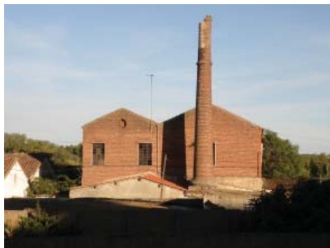
Fig. 17 Antigua fábrica de colas (Barrio de la Prosperidad, próxima al río)
