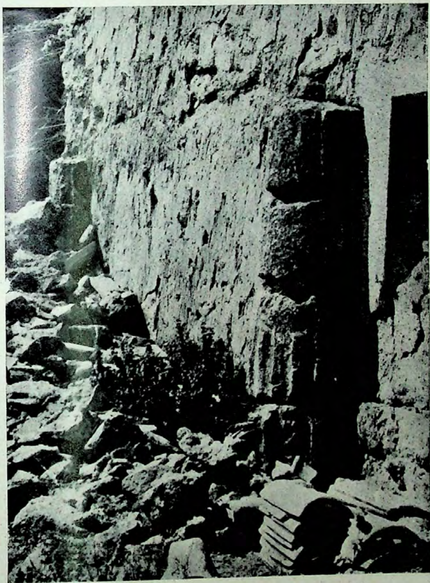
Lám. X.—Columnas in situ en el muro Norte de la Ermita de La Encarnación.
