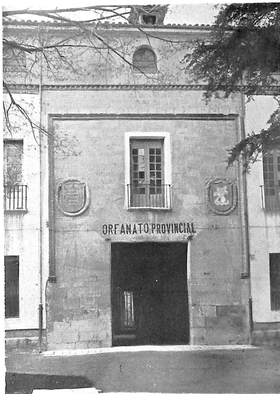
Lám. III.—Palacio del Conde de Benavente. Puerta principal (Fot. S. E. A. A.).
