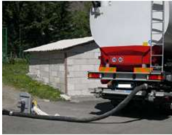
Figura 20. Descarga del pellet mediante sistema neumático (máx. 30 m)
