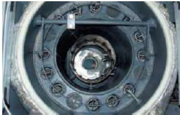
Figura 12. Intercambiador de calor
