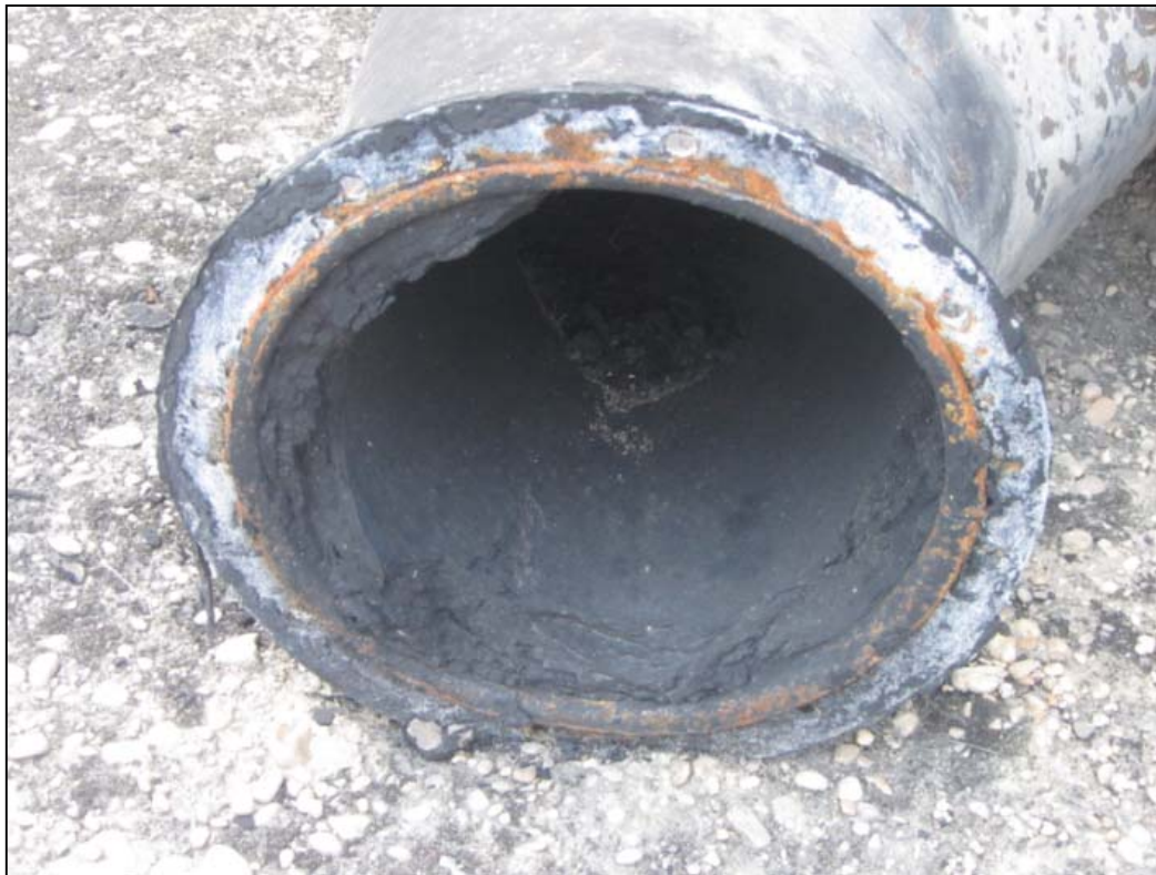
Figura 1-4-1. Conducto de aspiración de sistema viejo
