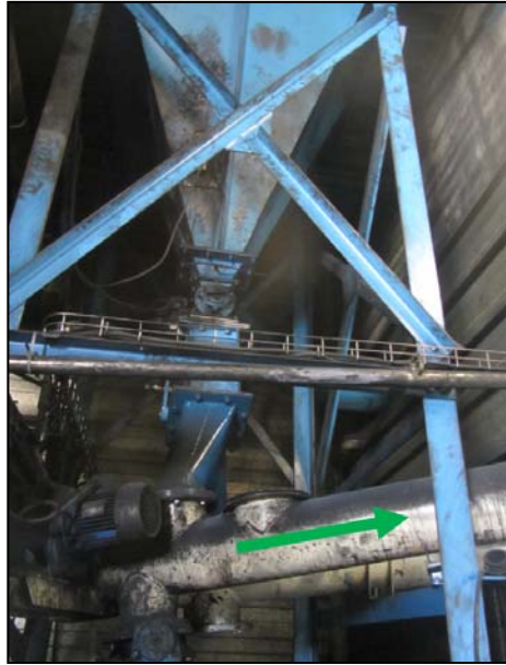
Figura 1-2-8. Recuperación automática de producto en caída de filtro
