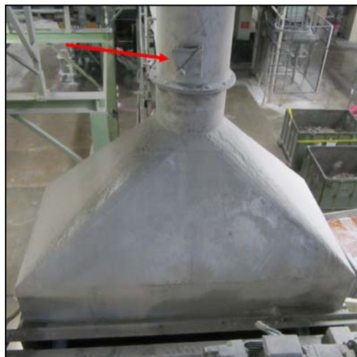
Figura 4-3-7. Llave de paso manual para obstrucción hipotética
