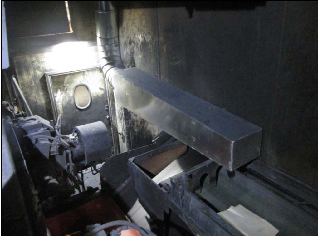
Figura 4-4-5. Campana de aspiración ramal prueba piloto
