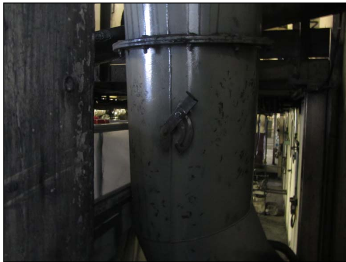
Figura 4-4-3. Llave de paso manual ramal prueba piloto
