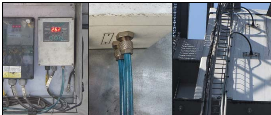
Figura 4-4-2. Configuración física del DPF 20 de aeautel en los filtros
