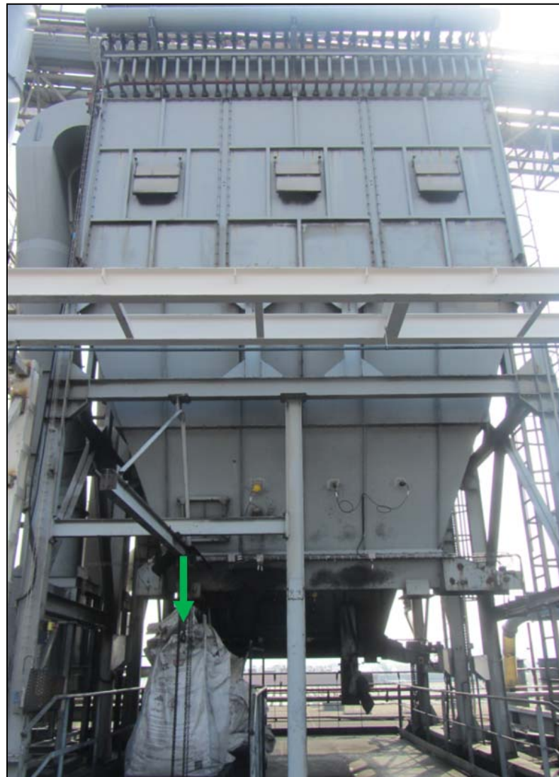
Figura 1-2-7. Recuperación manual de producto en caída de filtro
