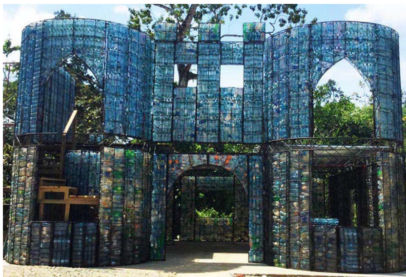
Figura 20. Casa de dos pisos creada con botellas enteras de PET ( Plastic Bottle Village 2017)
