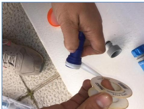
**Figura 3.30.**Aplicación de teflón en conexiones roscadas.
