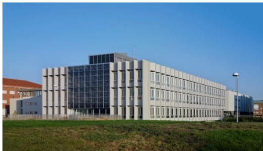
Figura 3.26. Paneles fotovoltaicos en fachada en el edificio LUCIA de la Uva
