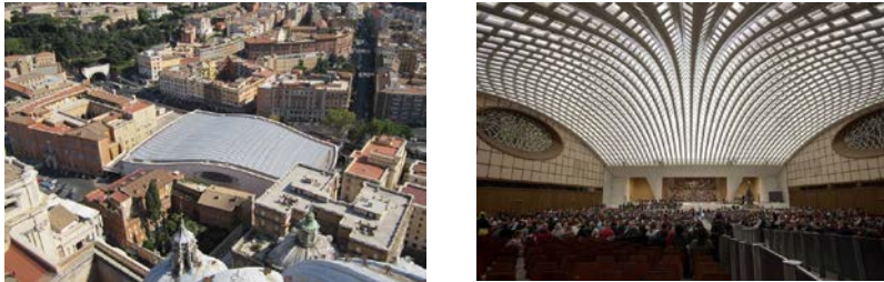
Figura 3.25. Paneles fotovoltaicos como cubierta acristalada del Aula Pablo VI, en Roma
