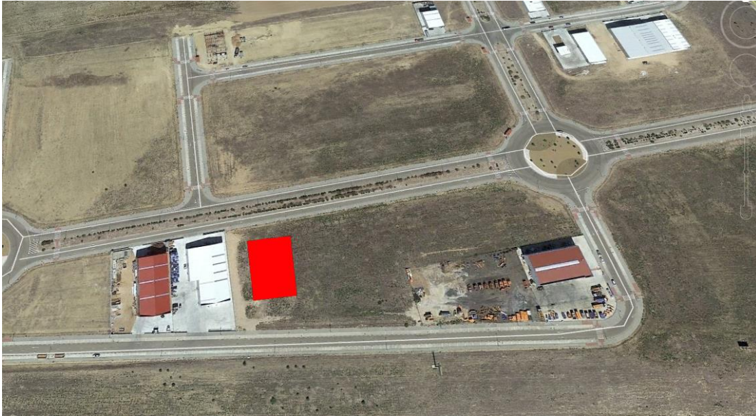
Figura 6.2: Suelo urbano de Dulces Galicia. Se ha indicado con un rectángulo rojo ya que está actualmente en construcción.
