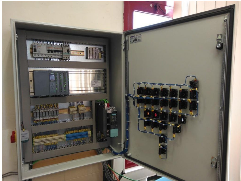
Figura 16: Armario eléctrico
