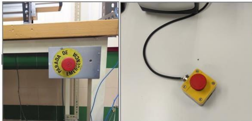
Figura 19 : Setas de emergencia
