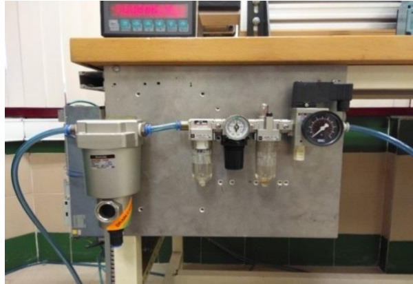
Figura 3 : Unidad de regulación y control de aire.
