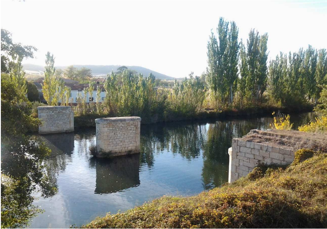
Figura 21: Pilares del antiguo puente del "Ferrocarril Secundario", sobre los que se instalará la pasarela de la senda, comunicando ambas orillas.
