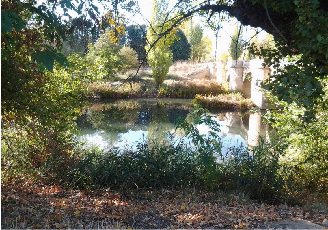
Figura 1: Aspecto de la sección 11 en las inmediaciones del "Puente Don Guarín", con discontinuidad longitudinal de la vegetación en el margen derecho y estado general bueno.
