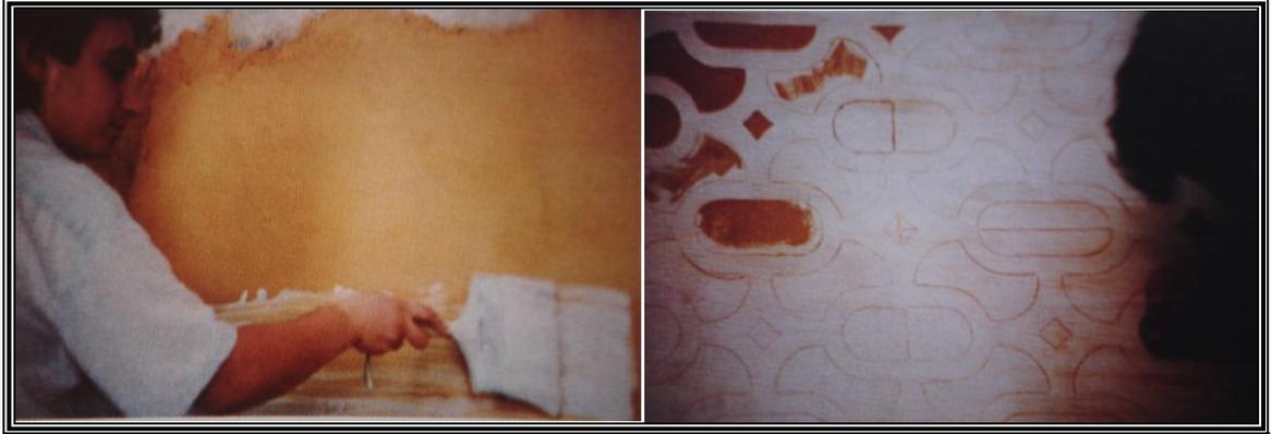
Fig.3: Ejemplo de esgrafiado acabado con cal.
