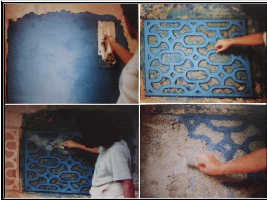
Fig.4: Ejemplo de esgrafiado embutido.
