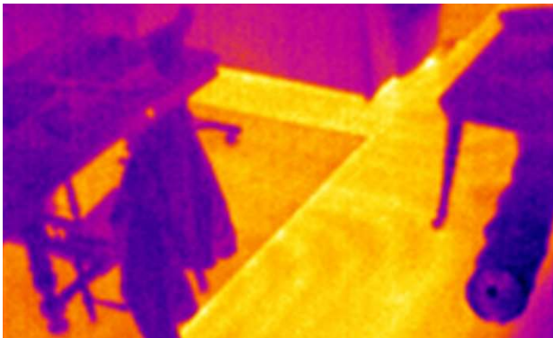
Figura 25. Trazado de suelo radiante visto con termografía.
