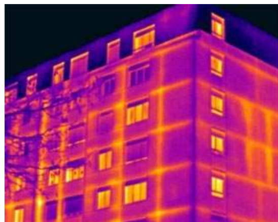
Figura 21. Uso de la termografía para identificar puentes térmicos en los frentes de forjados.
