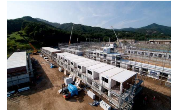
Fig. 61. Construcción de los contenedores
