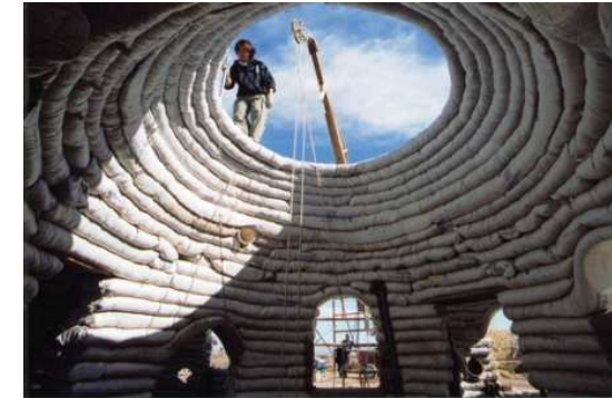
Fig.42. Vista interior construcción de Super Adobe
