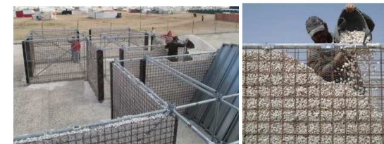
Fig.66. Construcción del centro educativo Makani Remedial, construcción de cerramientos y muros.
