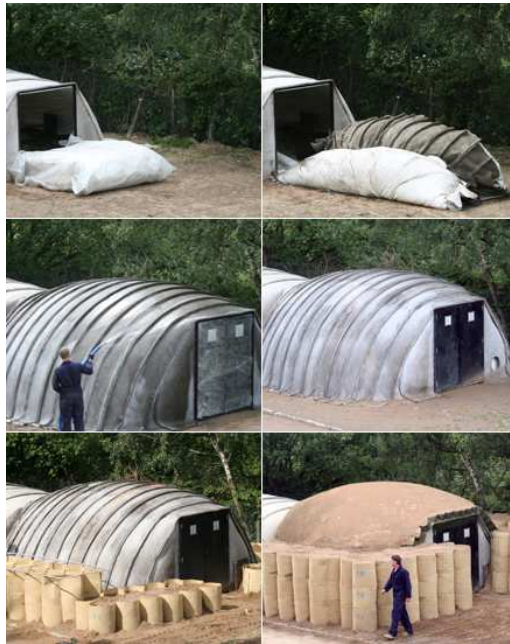
Fig.44. Montaje concrete cavas Helder
