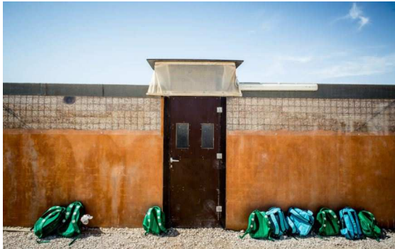
Fig.64. Construcción del centro educativo Makani Remedial, acabado de fachada
