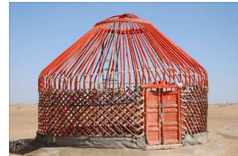
Fig.11. Estructura de la Yurta, tienda nómada de los pueblos de las estepas.
