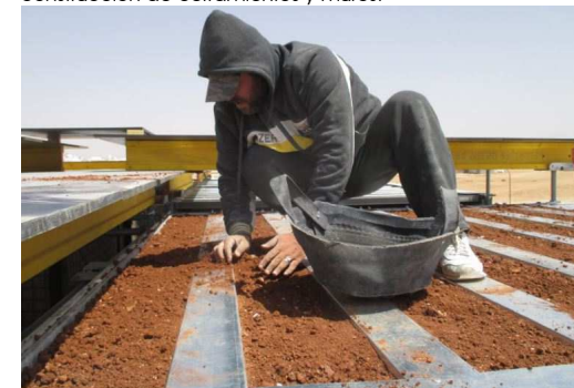
Fig.67. Construcción del centro educativo Makani Remedial, construcción de la cubierta.
