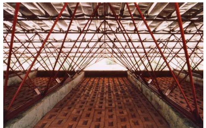
Fig 130 : Imagen de la estructura de la cubierta
