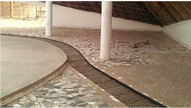
Fig 178 : Acabado de los canales
