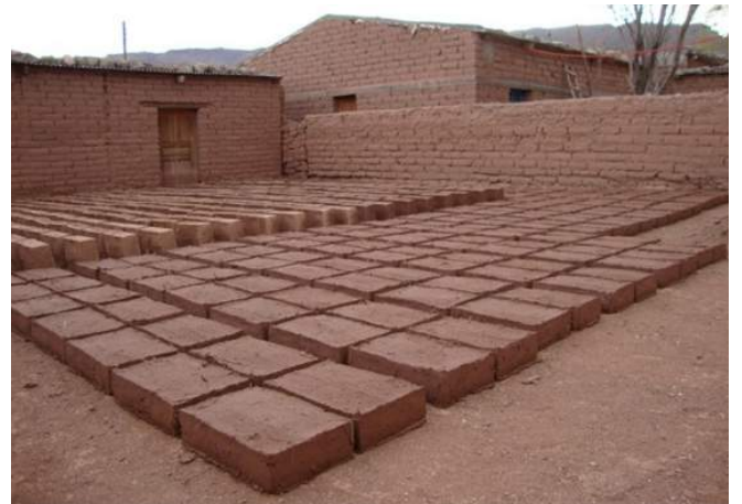
Fig. 67 : Secado y almacenamiento de bloques
