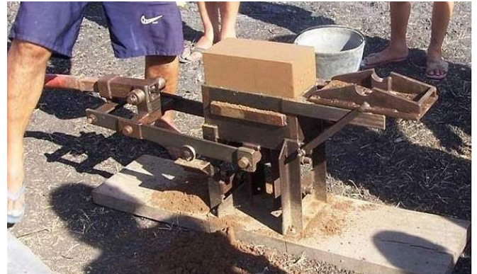
Fig. 66 : Ejecución de bloque
