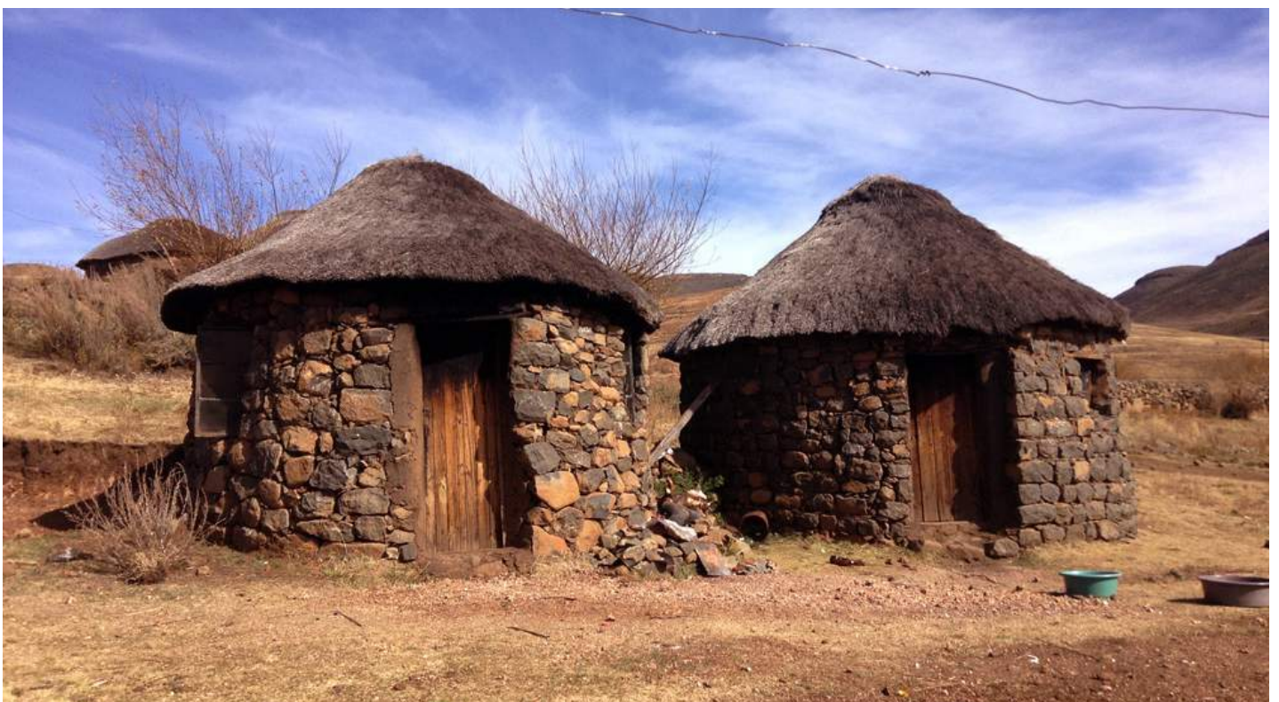
Fig 116 : Imagen de construcción circular ejecutada con muro de piedra
