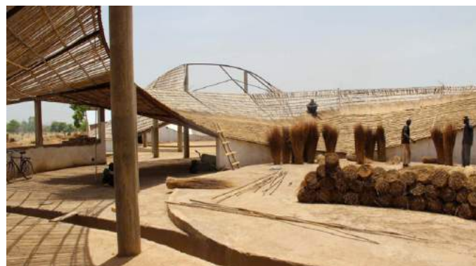
Fig 174 : Ejecución del acabado en paja de la cubierta
