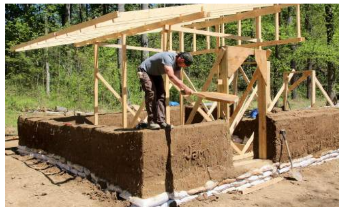
Fig. 44 : Golpeo y estabilización del muro
