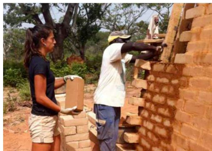
Fig 157 : Construcción del aula sobre la cimbra
