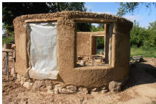
Fig. 52 : Ejecución de vanos
