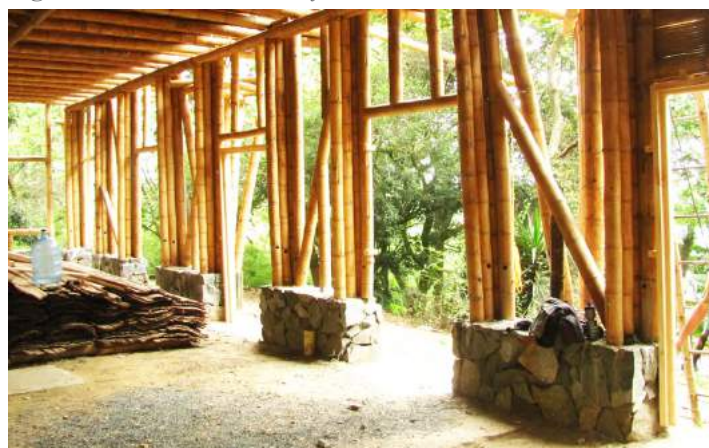
Fig. 86 : Construcción con zócalo
