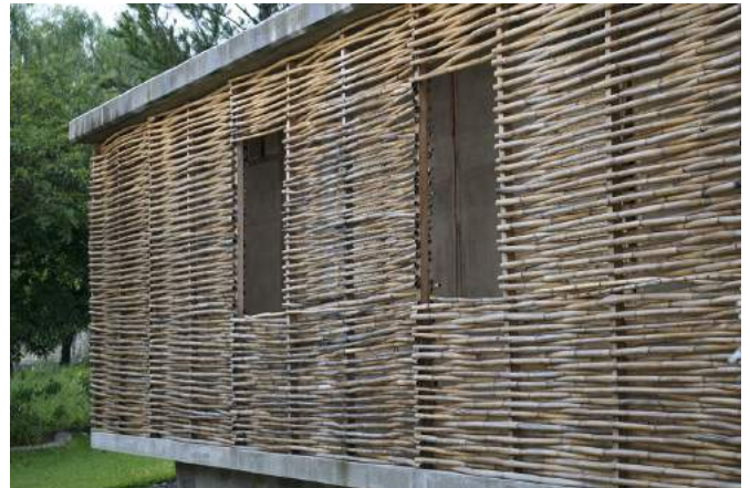
Fig 99 : Construcción de cerramiento con método Zarzo
