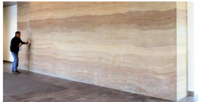
Fig. 54 : Acabado de muro de arcilla apisonada
