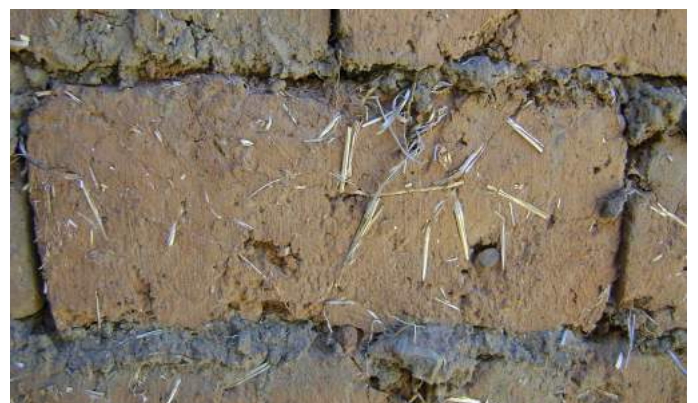
Fig. 31 : Presencia de paja en el barro como refuerzo
