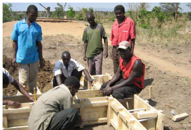
Fig. 58 : Ejecución de muro: Colocación del encofrado
