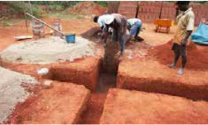
Vertido del material sobre las rozas de la cimentación
