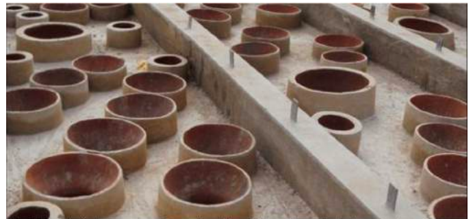
Fig 140 : Imagen de la cubierta en detalle
