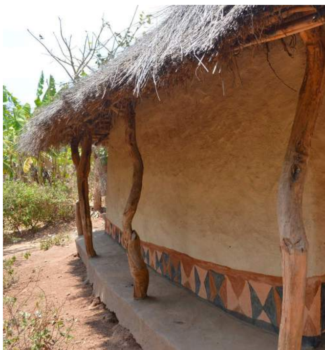
Fig. 50 : Acabado exterior con cal
