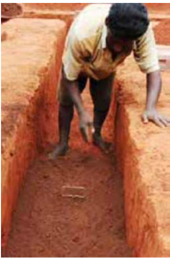
Vertido del material sobre las rozas de la cimentación
