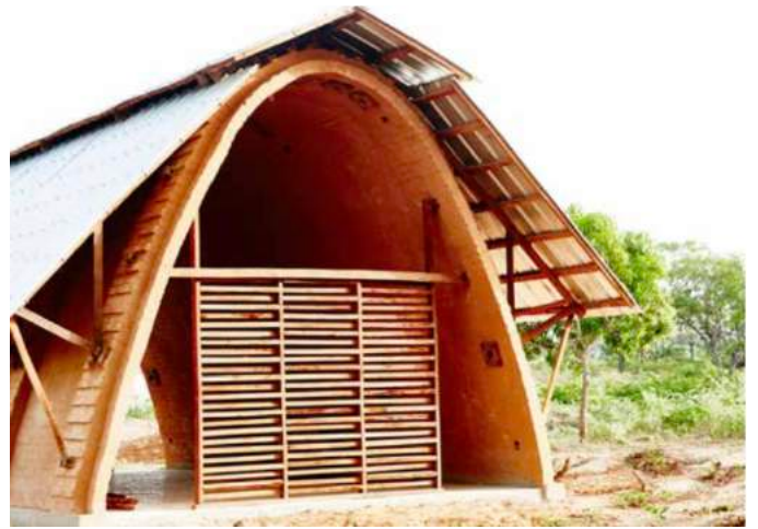
Fig 161 : Imagen exterior del aula
