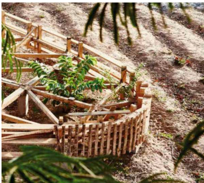
Fig 155 : Finalización de la cimbra
