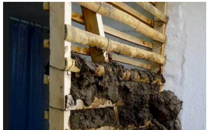
Fig 103 : Muro ejecutado con bambú y cob
