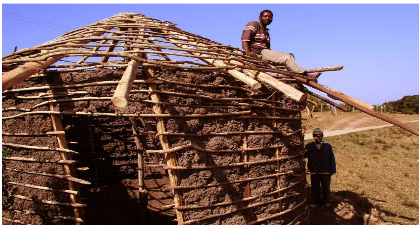
Fig 120 : Imagen de construcción circular ejecutada con muro mixto
