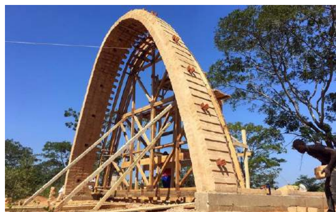
Fig 158 : Movimiento de cimbra
