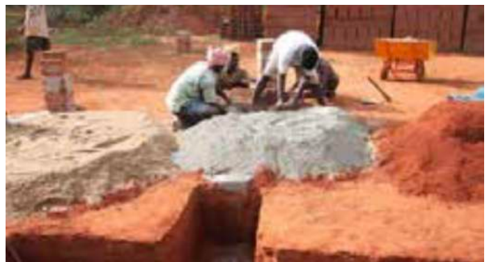
Adición de 200l de arena y una bolsa de cemento (50kg)
