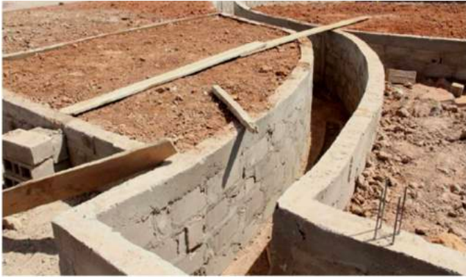
Fig 177 : Ejecución de los canales
