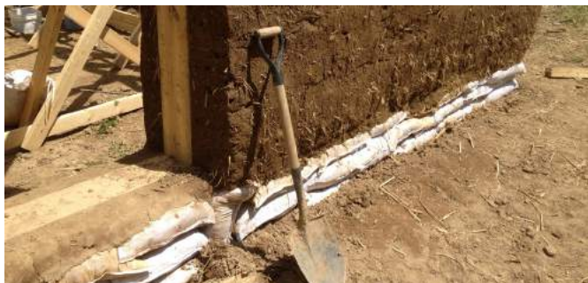
Fig. 40 : Muro de COB
