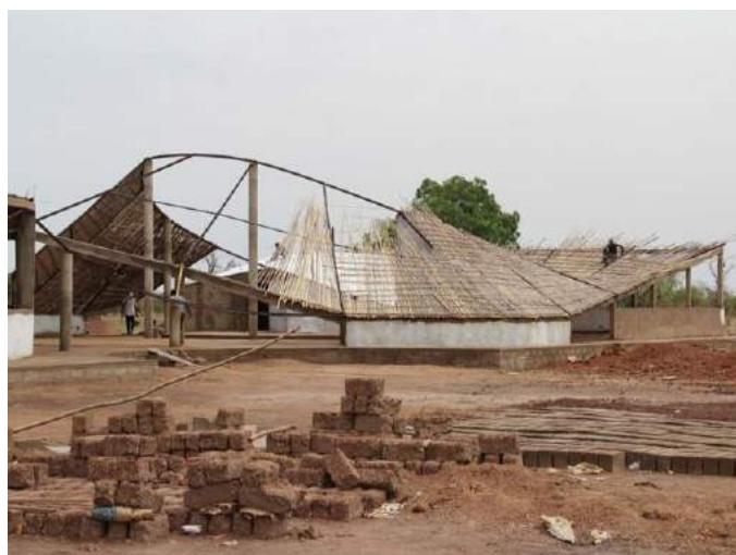
Fig 173 : Ejecución de la cubierta
