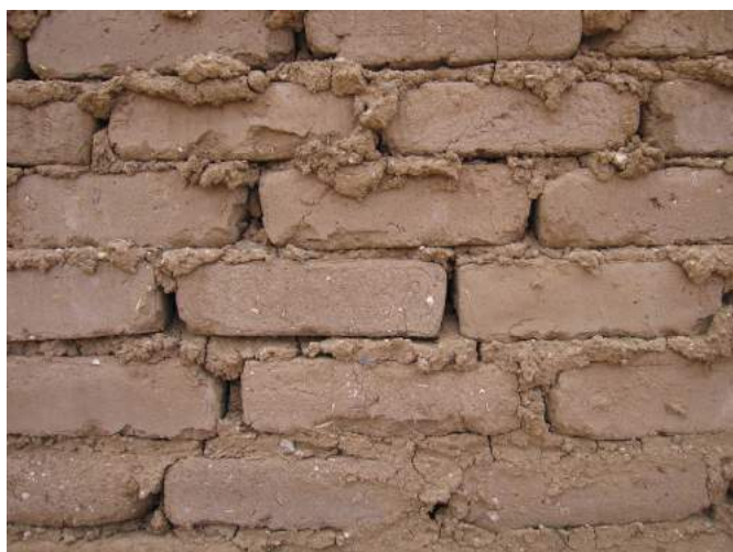
Fig. 49 : Unión con mortero entre bloques de adobe
