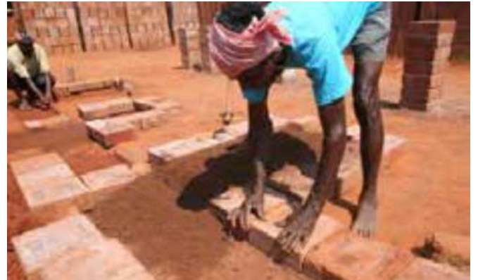
Cuando el nivel de la cimentación sobresale del del terreno se colocan bloques de tierra formando un zócalo
