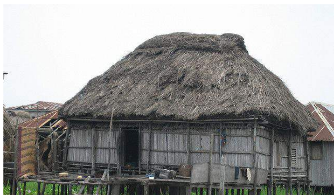
Fig. 90 : Acabado de cubierta de bambú
