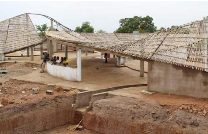
Fig 179 : Construcción del aljibe
