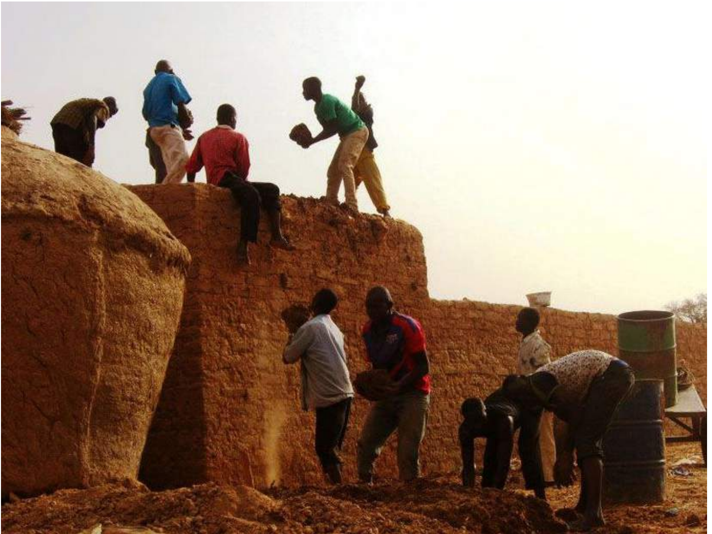
Fig. 22 : Imagen de construcción con tierra
