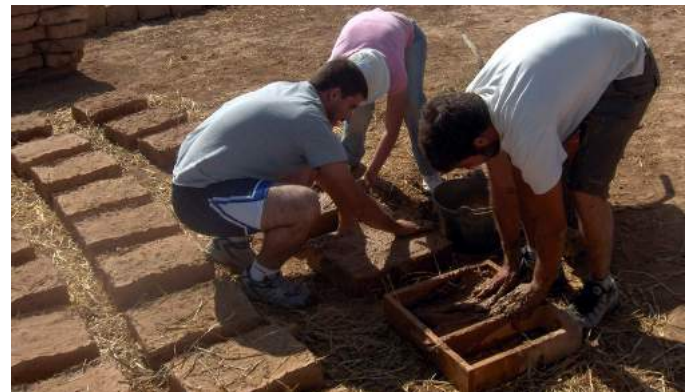
Fig. 47 : Elaboración de bloques de adobe
