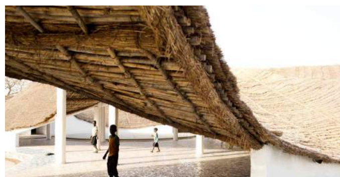
Fig 175 : Vista interior de la cubierta
