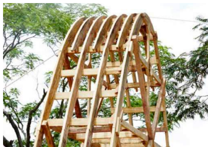
Fig 156 : Elevación de la cimbra
