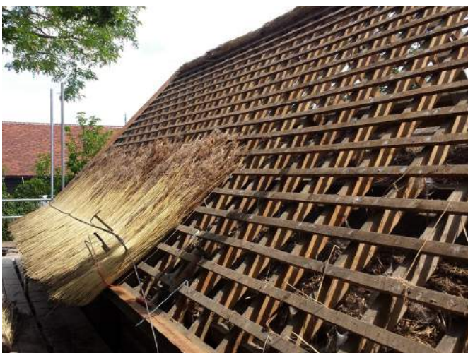
Fig 106 :Estructura de la cubierta con soporte de madera
