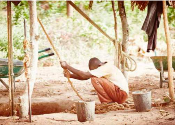
Fig 150 : Extracción de tierra para posterior manipulación
