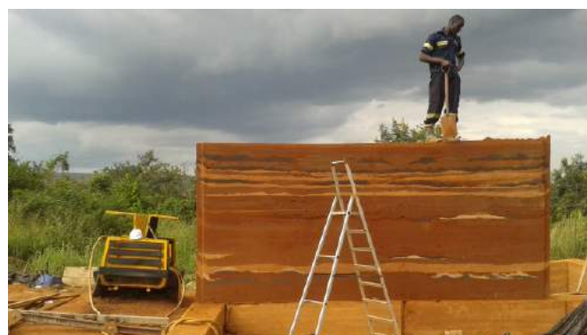
Fig. 61 : Ejecución del muro: Acabado
