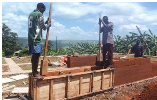
Fig. 59 : Ejecución de muro: Vertido de material
