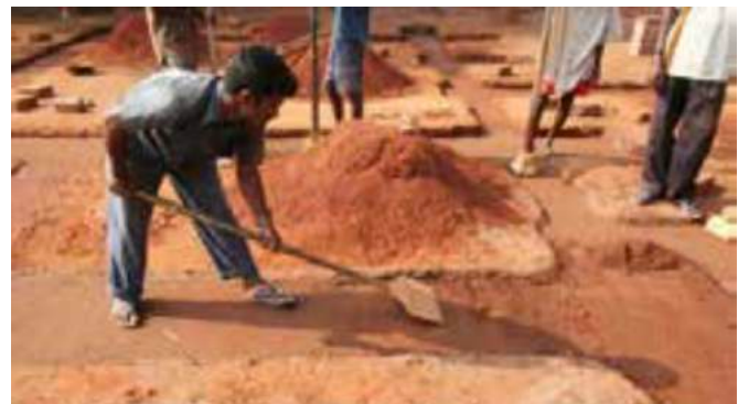
Nivelado del de la última capa de cimentación
