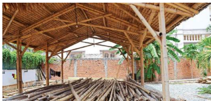
Fig. 84 : Diseño de voladizos como método de protección
