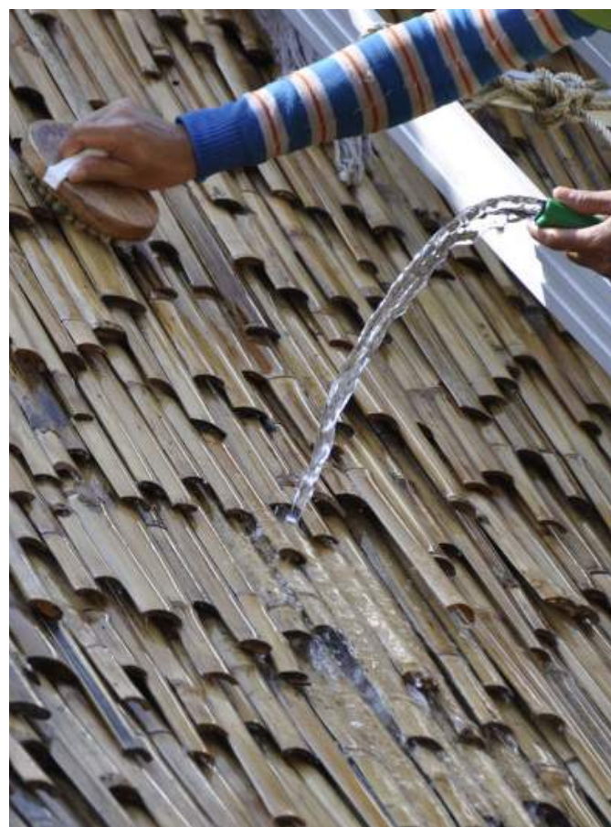
Fig. 92 : Acabado de cubierta con teja de bambú
