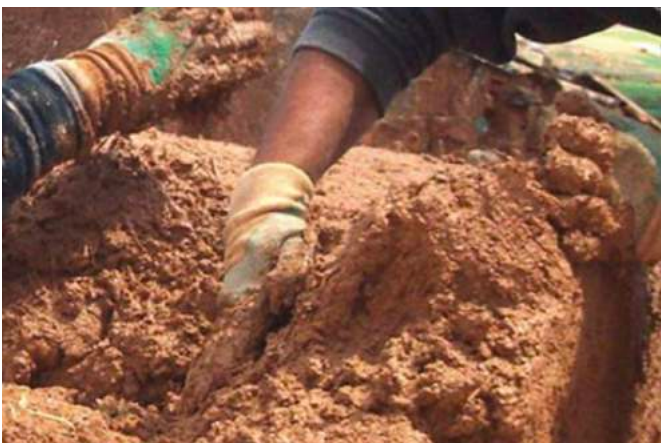
Fig 98 : Elaboración de muro con método COB
