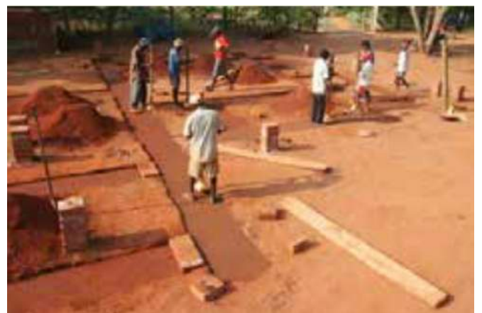
Regulación previa al secado de la cimentación
