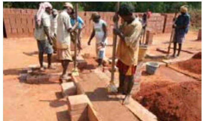
Compactación de la última tongada
