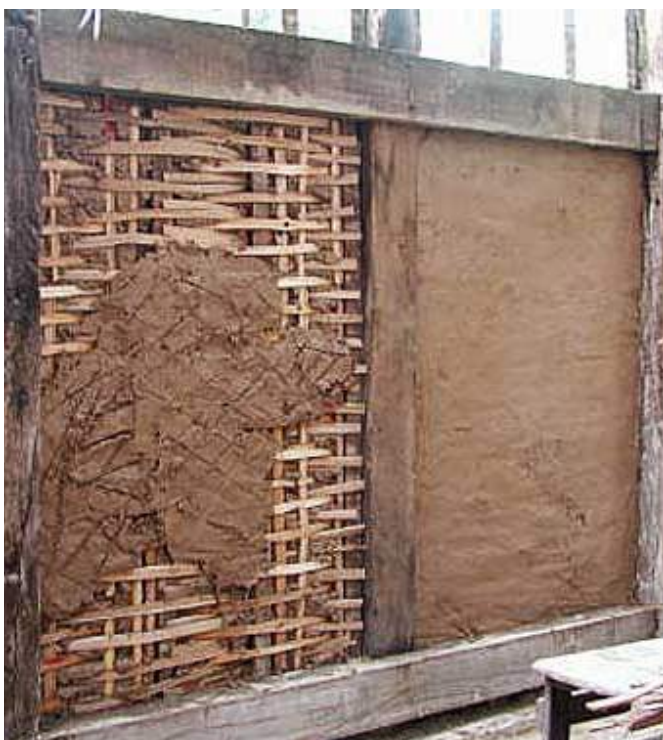
Fig 102 : Muro ejecutado con sistema Bahareque
