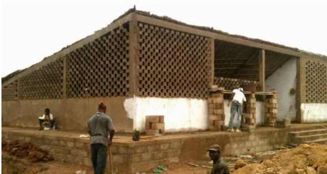
Fig 168 : Imagen de la ejecución de muros
