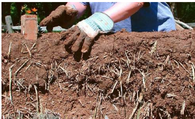
Fig. 42 : Ejecución de muro con fibras vegetales
