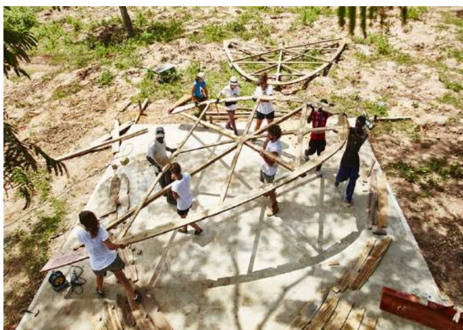
Fig 154 : Ejecución de la cimbra
