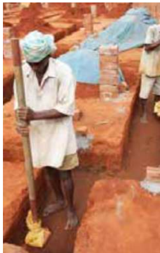
Ajuste de la roza a medida que se ejecuta la cimentación
