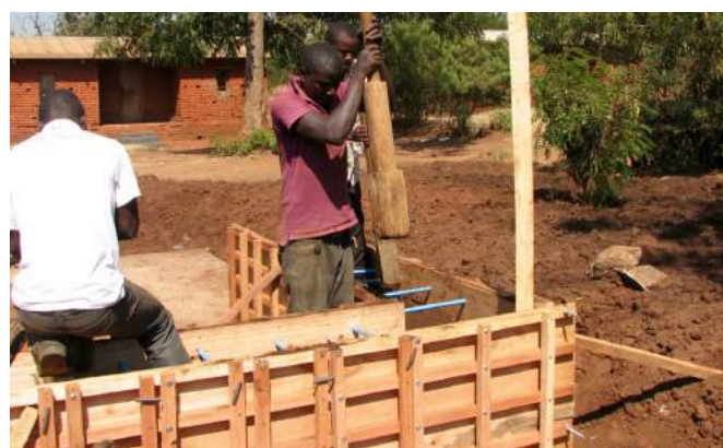
Fig. 60 : Ejecución del muro: Apisonado
