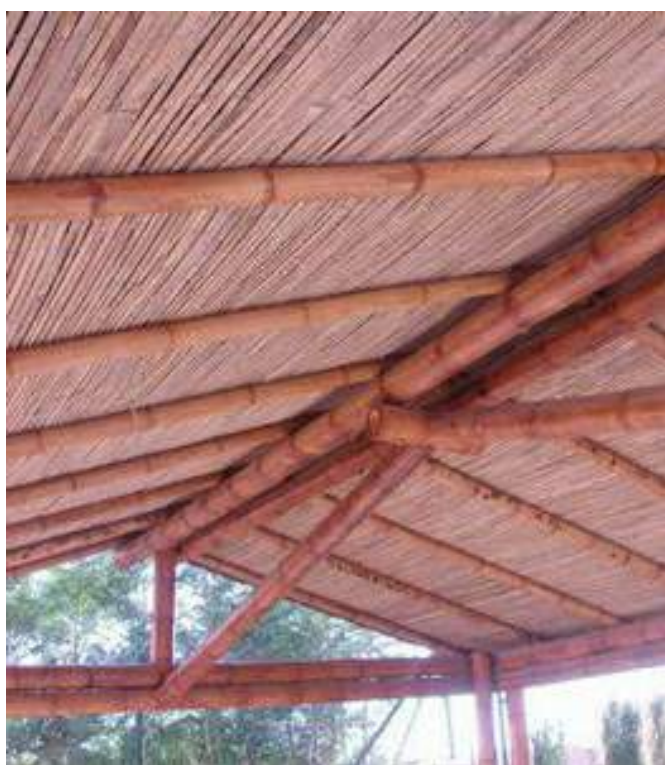
Fig. 88 : Cubierta de bambú a dos aguas wwwdebambu.net
