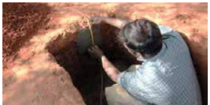
Marcado del nivel de altura de de la zapata
