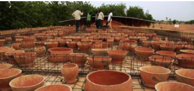
Fig 137 : Imagen de la construcción de la cubierta
