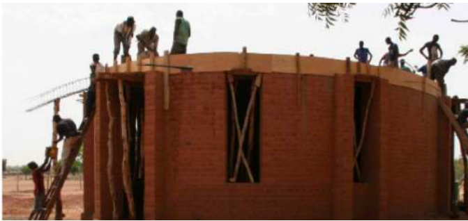
Fig 136 : Imagen de la construcción de la biblioteca
