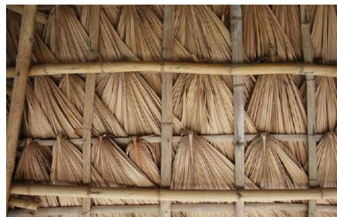
Fig 113 : Vista interior del acabado de la cubierta
