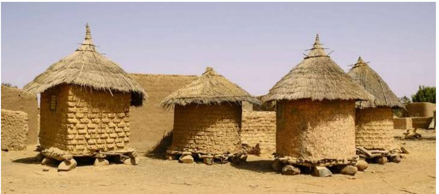
Fig 122 : Imagen de construcción circular ejecutada con muro de COB
