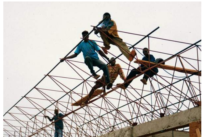
Fig 129 : Imagen de la cobertura metálica de la cubierta
