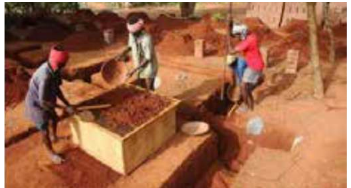
Colocación de 500l de tierra para preparar la mezcla
