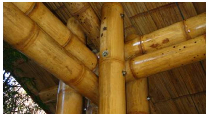
Fig. 76 : Imagen de unión entre elementos de bambú
