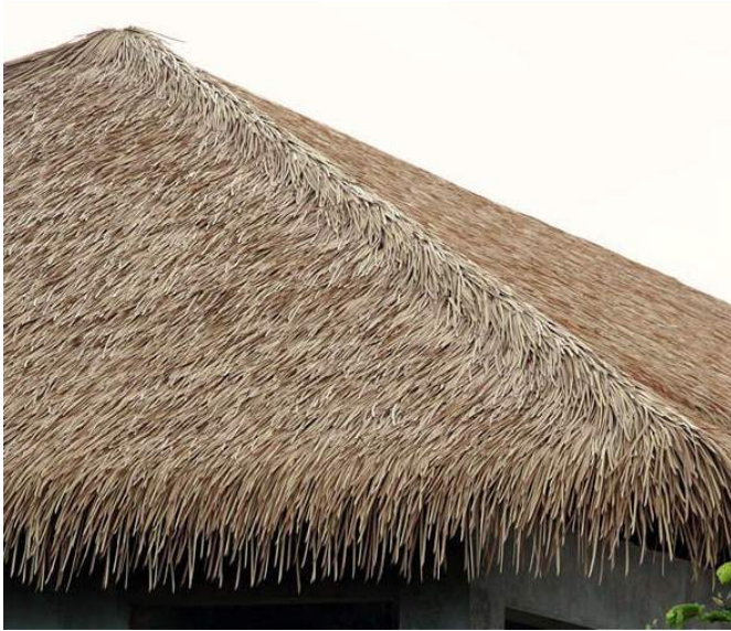
Fig 105 : Acabado de cubierta con paja
