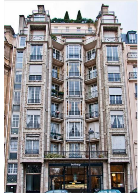
Fig.38: Rue Tretaigne, 25 bis, Perret
