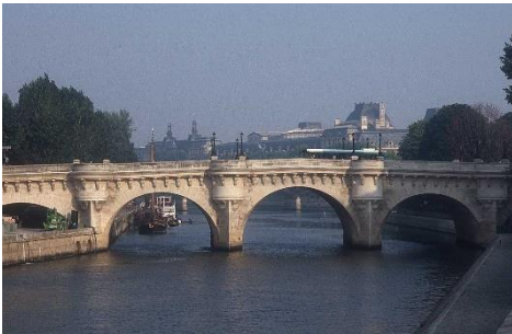
Fig.50,51: Imágenes del Pont Neuf, Paris.
