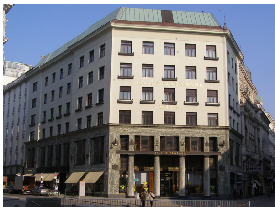
Fig. 62 Fotografía de la Looshaus
