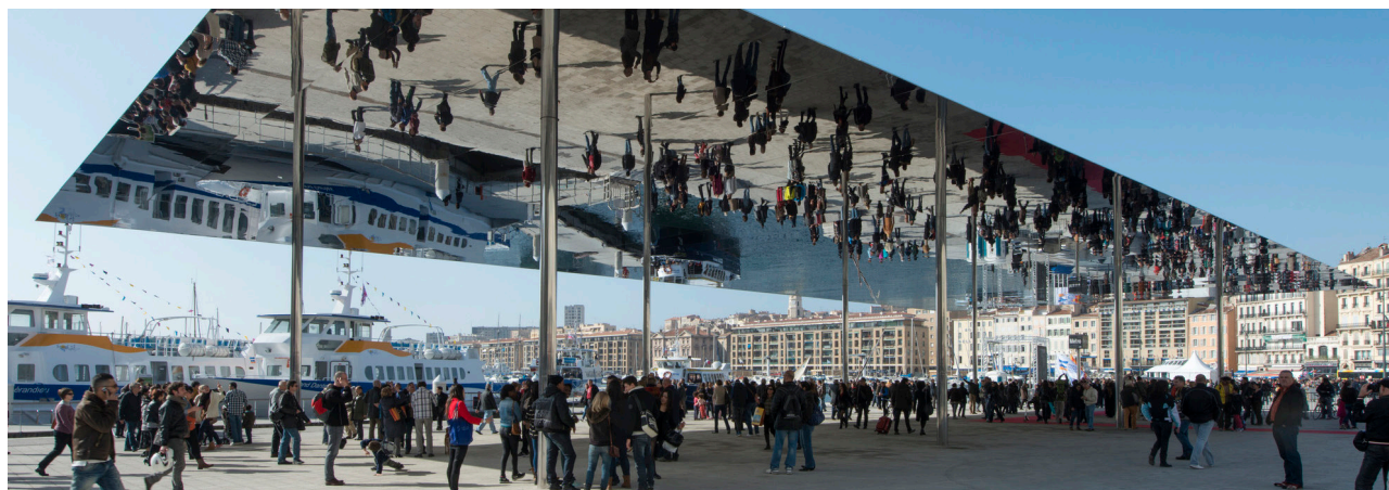
Fig. 12 Fotografía del pabellón Vieux Port
