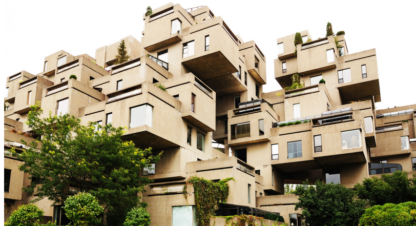
Fig. 49 Foto del edificio hábitat 67
