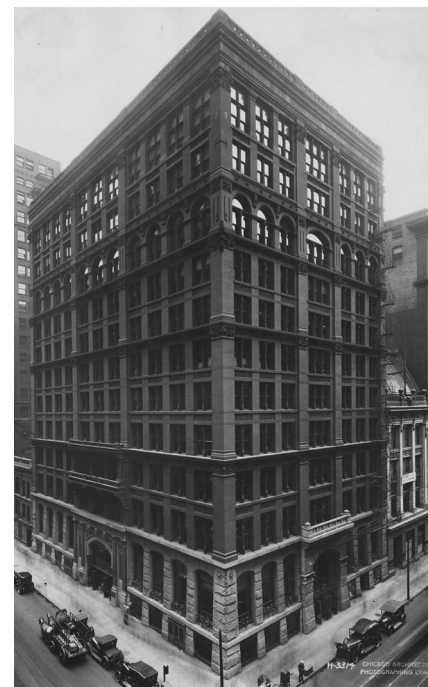
Fig. 61 Fotografía del Home Insurance Building
