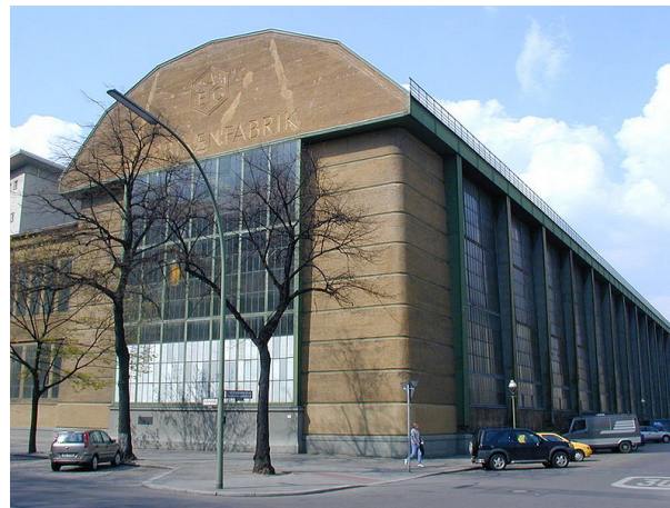
Fig. 60 Fotografía Nave de turbinas AEG
