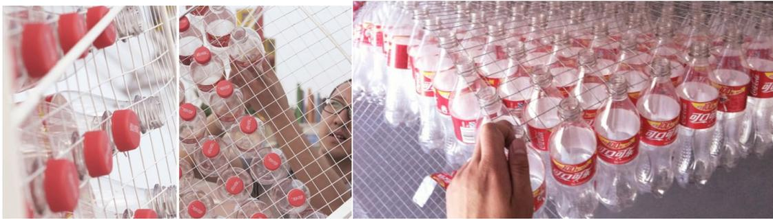
Ilustración 21. Botellas de una misma marca sujetadas con una malla cuadrada para crear una cubierta. <https://www.creativespotting.com/2015/03/upcycled-coca-cola-plastic-bottle-pavilion/>
