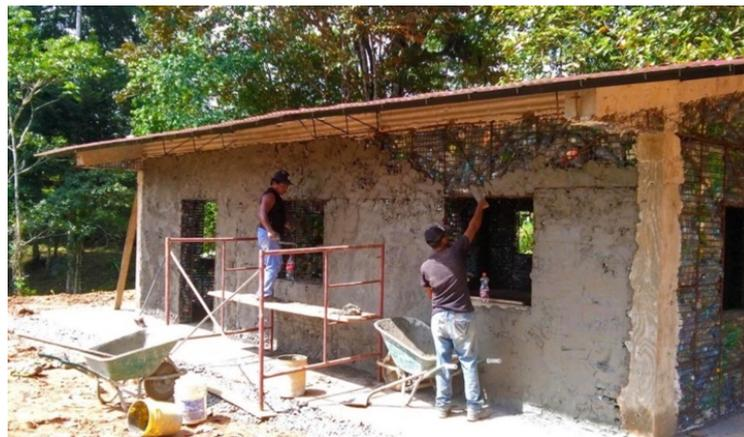
*Ilustración 13. Revoque de cemento para hacer una superficie lisa y darle un acabado a la fachada de la vivienda.*
