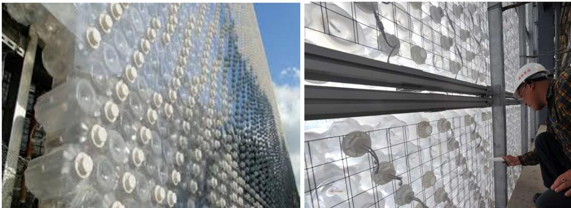
Ilustración 15. Detalle de los ladrillos ecológicos diseñados por Arthur Huang, [https://www.plataformaarquitectura.cl/cl/02-290580/ecoark-en-taiwan-una-mega-estructura-construida-con-botellas-de-plastico-recicladadas?ad\\_medium=gallery](https://www.plataformaarquitectura.cl/cl/02-290580/ecoark-en-taiwan-una-mega-estructura-construida-con-botellas-de-plastico-recicladadas?ad_medium=gallery)
