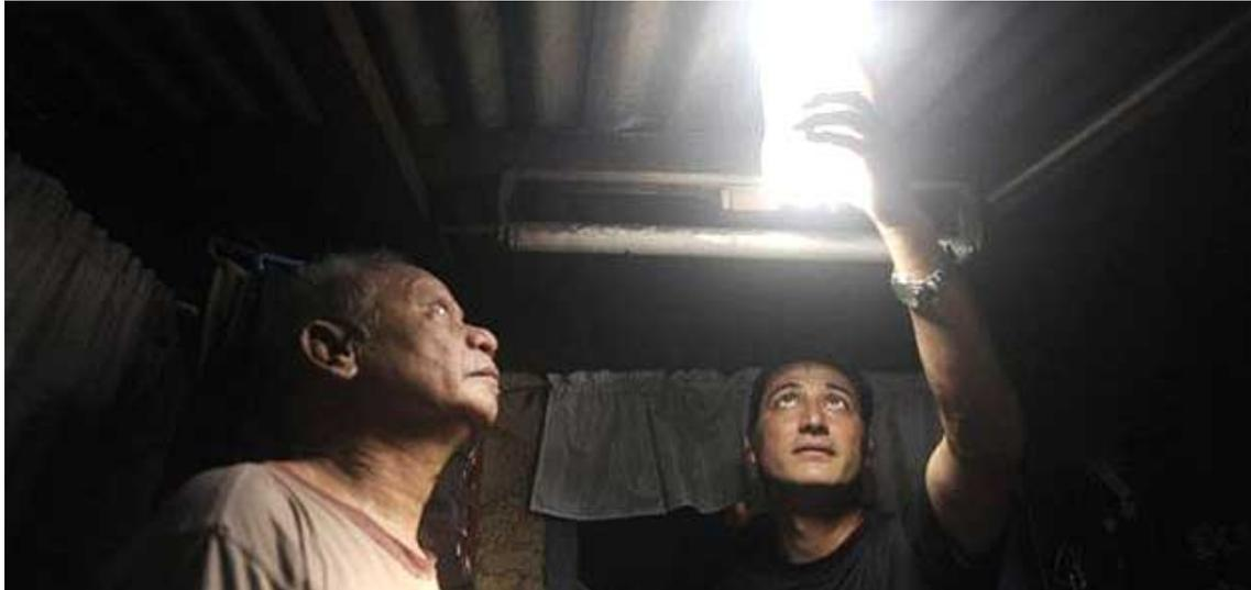
Ilustración 45. Acabado final de la instalación de una lámpara Móser.
