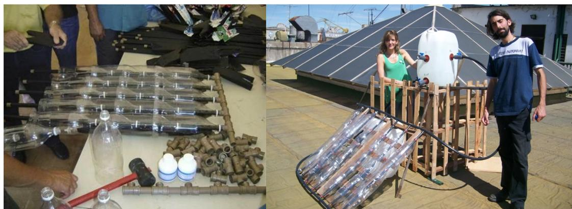
Ilustración 41. Izquierda. Proceso de montaje del calentador solar. Derecha. Acabado final del calentador solar realizado con botellas de plástico reutilizadas. <http://papascreativas.blogspot.com/2015/08/como-construir-un-calentador-solar.html>
