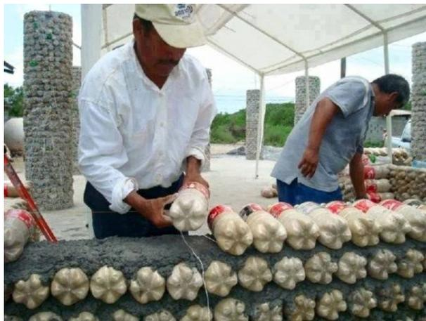
*Ilustración 11. Colocación de botellas recicladas de plástico en hiladas.*
