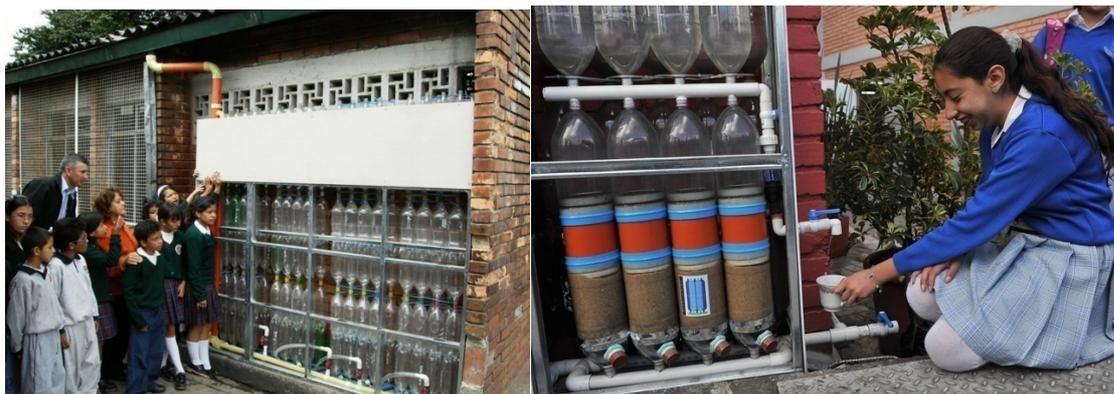
Ilustración 43. Izquierda. Acabado final del Ekomuro H2O. Derecha. Sistema de filtro purificador para potabilizar el agua. <https://www.bioguia.com/notas/como-construir-una-pared-recolectora-de-agua-de-lluvia-con-botellas-de-plastico>
