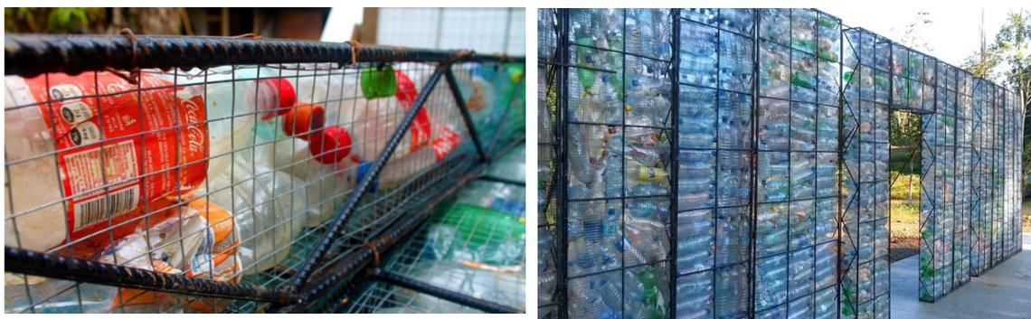
Ilustración 12. Izquierda y derecha. Sistema de muro creado por malla metálica haciendo las funciones de una especie de gavión. <https://www.elperiodico.com/es/extra/20161110/primer-pueblo-botellas-plastico-5619886>
