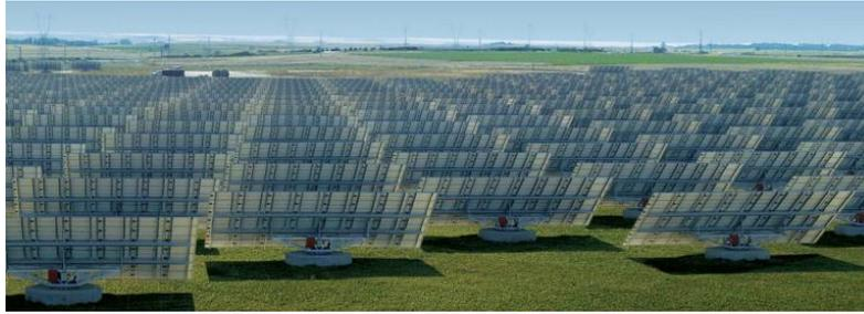
*Figura 2.21.* Seguidor azimutal de un eje.
