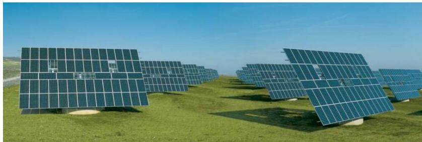
*Figura 2.22.* Seguidor solar de dos ejes.
