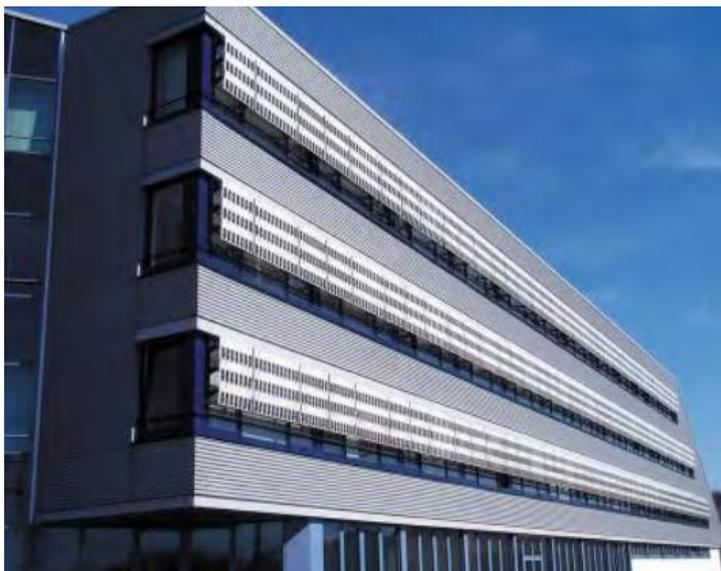
*Figura 3.22.* Integración fotovoltaica en los parasoles de Eschweiler.
