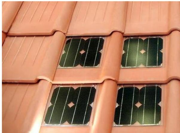
**Figura 3.14.** Teja "tegasolare".
