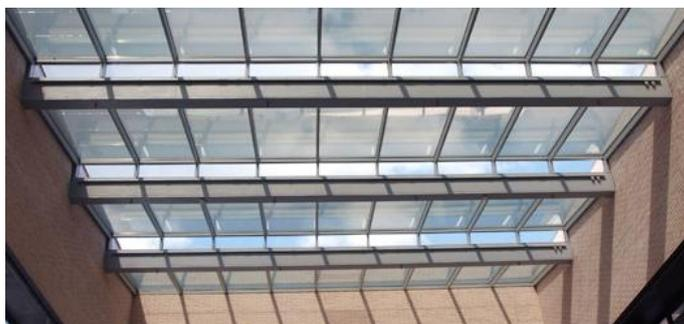
*Figura 3.5.* Vidrios con estructura de doble acristalamiento integrado por Onyxsolar.
