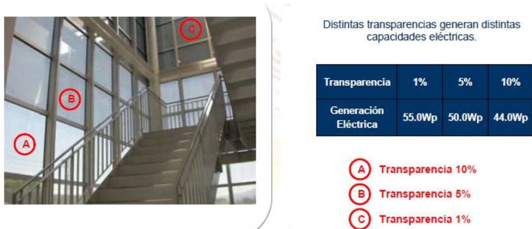
**Figura 3.7.** Módulos fotovoltaicos en función de su transparencia y generación eléctrica
