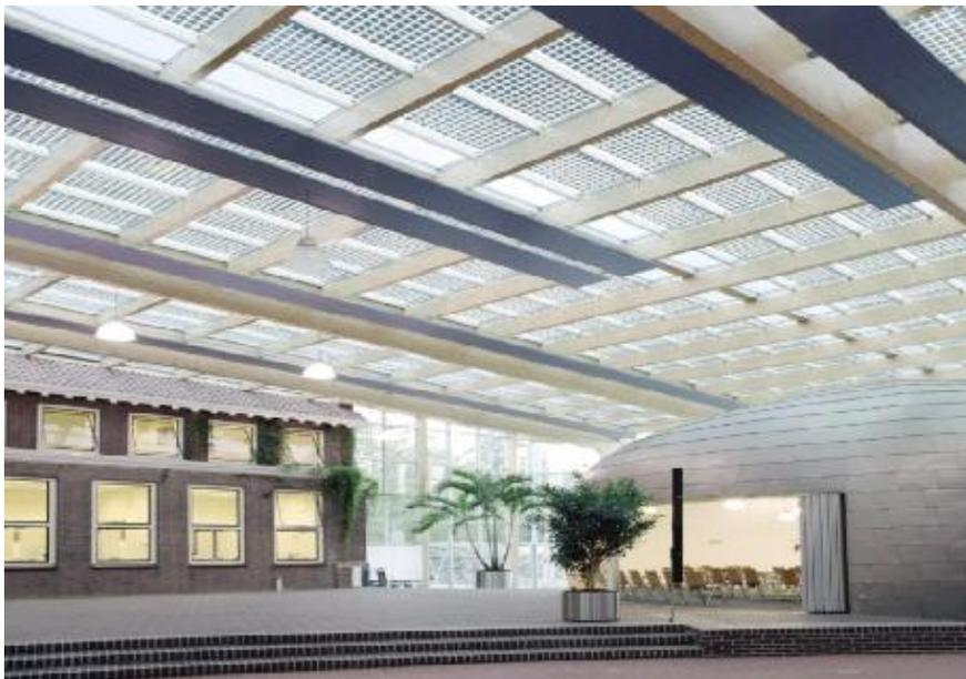
*Figura 3.16.* Instalación de módulos en cubiertas acristaladas.
