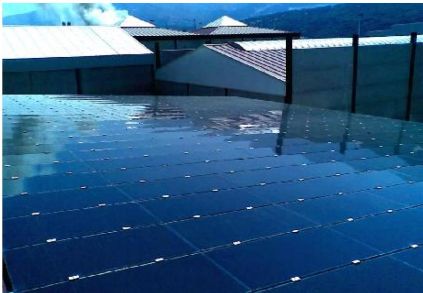
*Figura 3.12.* Integración de módulos en cubiertas inclinadas por superposición.
