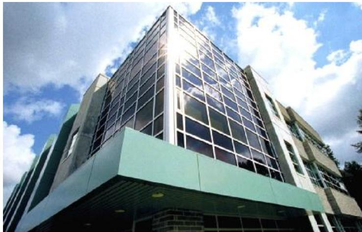
*Figura 3.18.* Integración de módulos fotovoltaicos en muros cortina.
