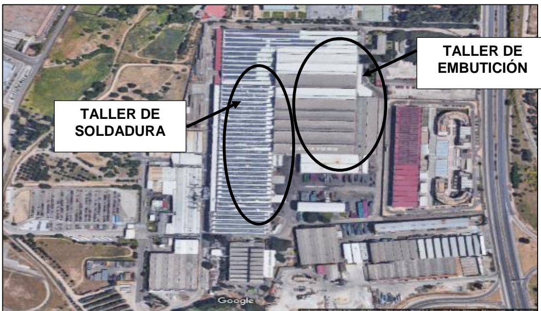
Ilustración 76: Vista aérea del Taller de Embutición y del Taller de Soldadura.
