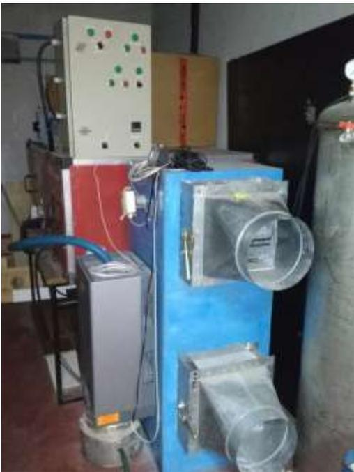
Figura 22. Vista de la UTA y el plenum de distribución.
