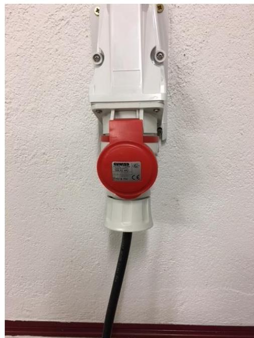
Figura A6.7: Conexión a la red trifásica 400V.
