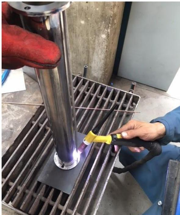
*Figura 3.33: Ejecución del primer punto de soldadura en la unión del tubo de acero con la brida.*
