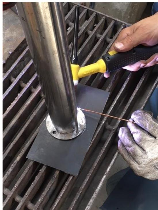
*Figura 3.35: Realización del cordón de soldadura en la unión del tubo de acero con la brida.*
