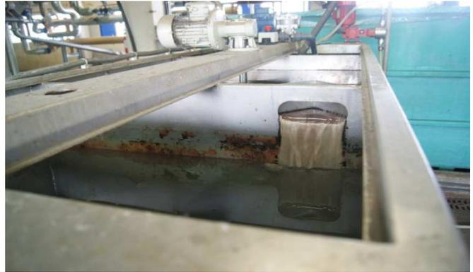
Figuras 3.3, 3.4 y 3.5. Contenedor de dilución de polielectrolito. Detalles del primer subcompartimento donde se introduce el caudal de polielectrolito concentrado y del último subcompartimento, zona de dosificación.
