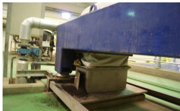
Figura 3.7 y 3.8. Centrifugas de deshidratación. Detalle del punto de toma de muestras para sequedad.
