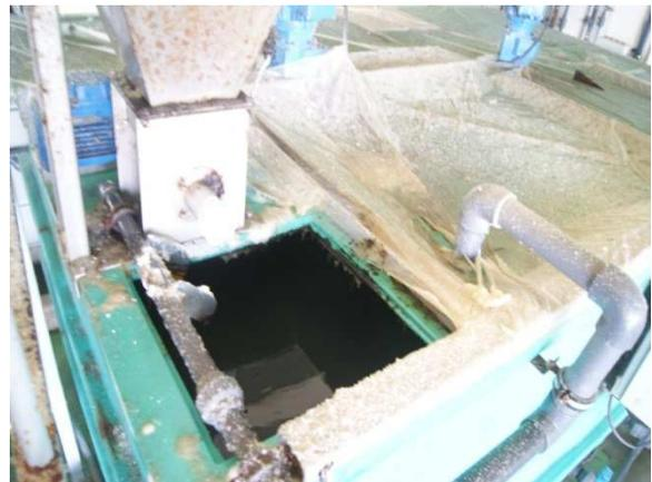
Figuras 3.1 y 3.2. Equipo de dosificación y preparación de polielectrolito.
