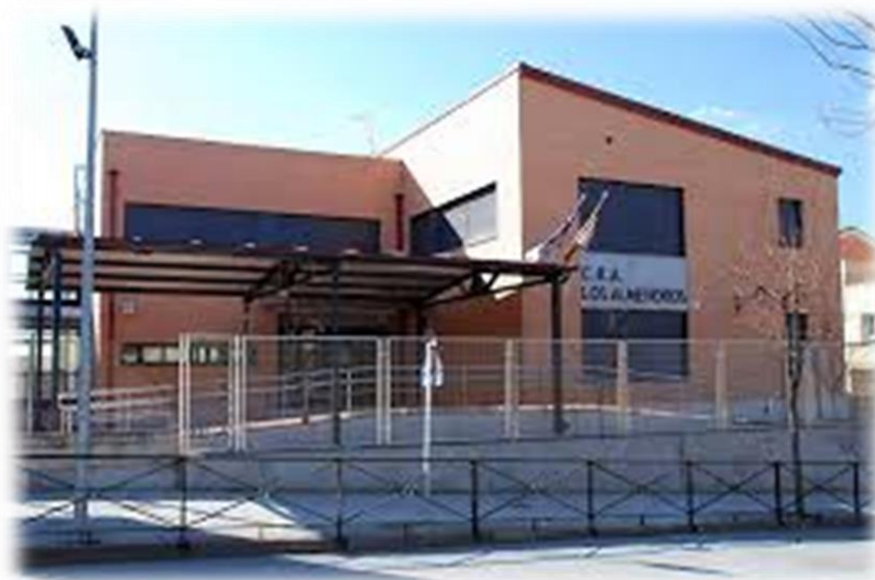
Ilustración 28. Fachada del colegio CRA Los Almendros de La Lastrilla.
