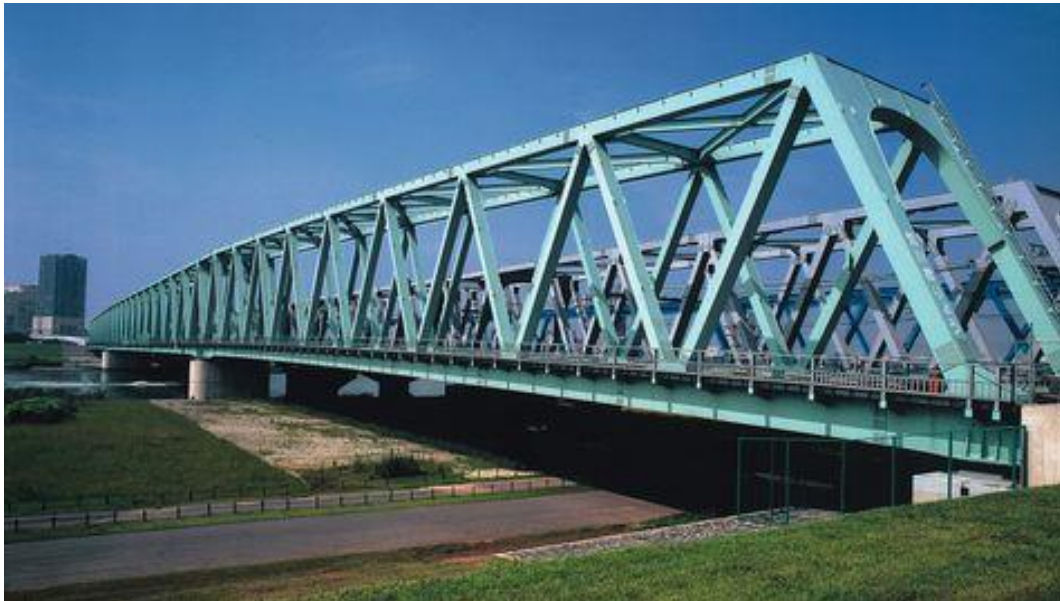
Figura 17: Puente ferroviario con tipología Warren.
