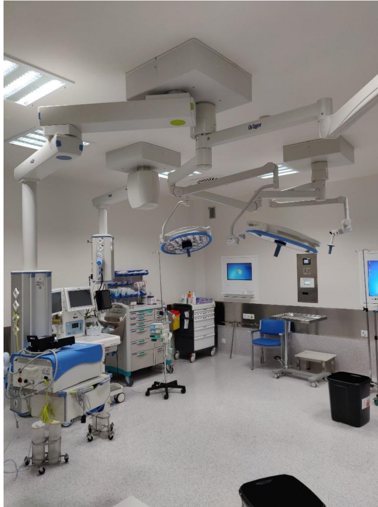
Figura 7: Quirófano Q37, de tipo A
