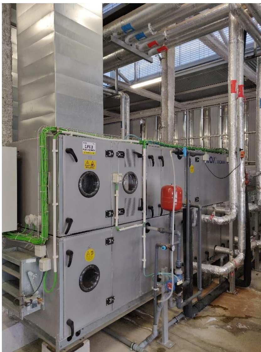
Figura 9: UTA del quirófano Q37
