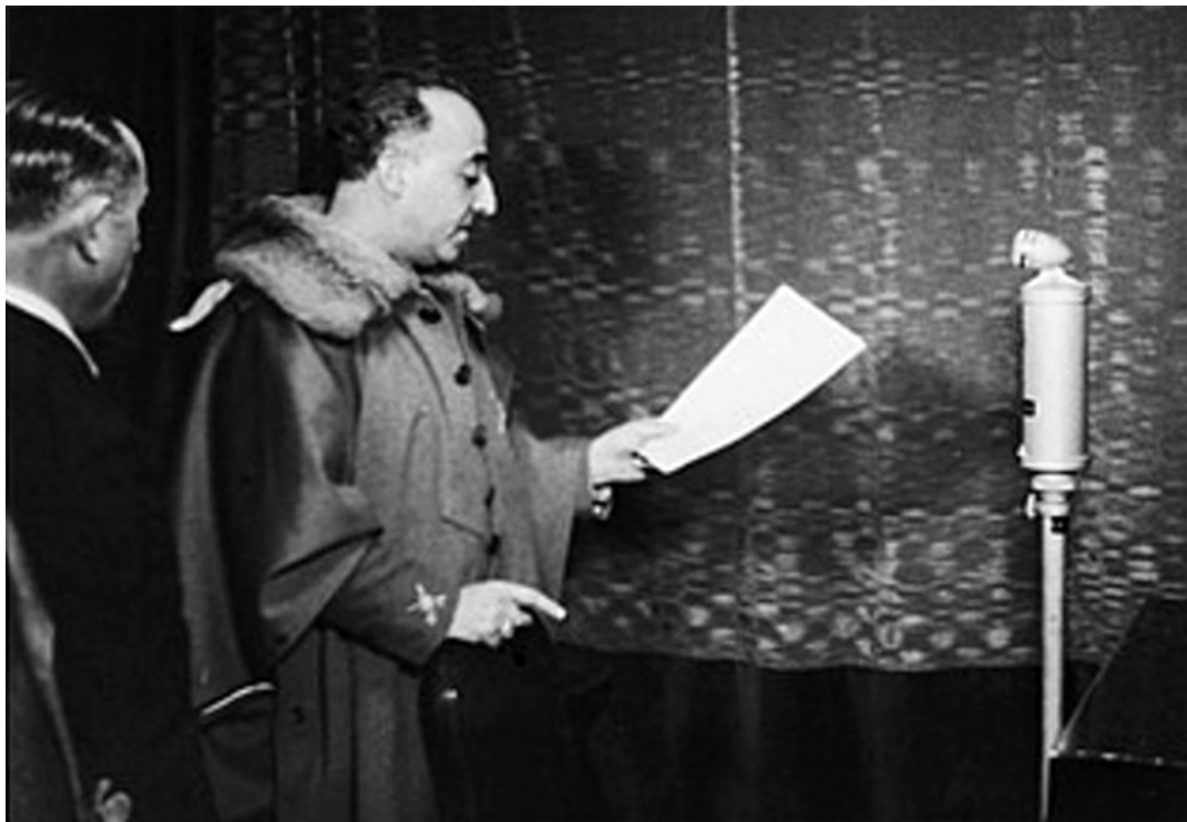
Figura 3: Alocución de Francisco Franco a través de los micrófonos de Radio Castilla en Burgos, 1 de octubre de 1936. Fuente: Historia de la radio.
