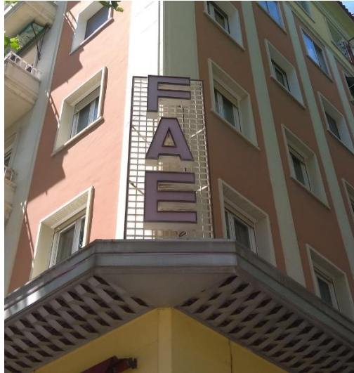
Ilustración 1.1. Fachada lateral del actual Teatro GM. Fuente: elaboración propia.
