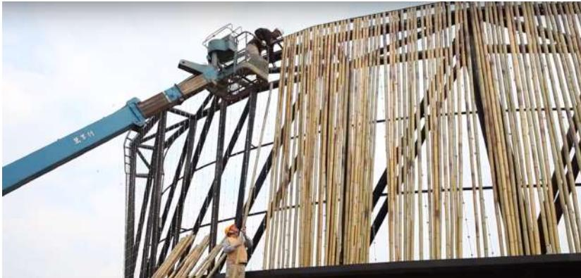
Ilustración 113. Proceso de construcción del anillo\_fragmento del vídeo de Delta CSR
