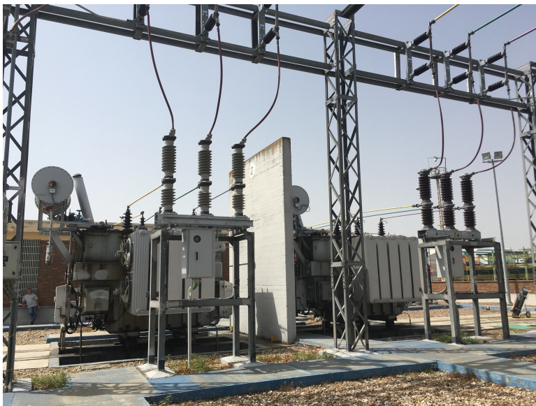
Figura 2.2.5. Transformadores del parque de 44 kV.
