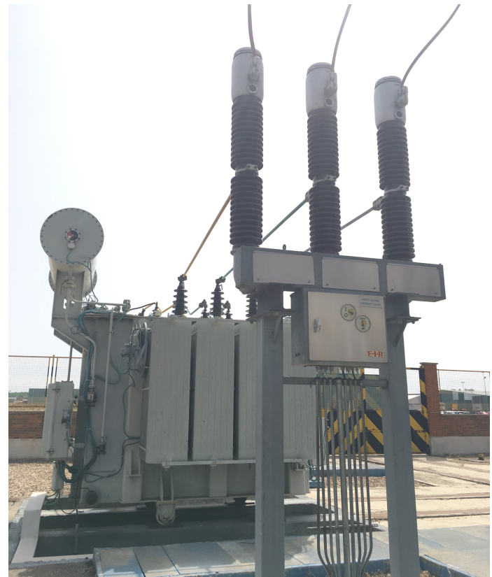
Figura 2.2.5. Transformadores del parque de 44 kV.
