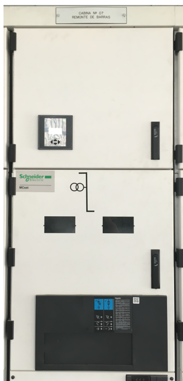
Figura 3.3.2. Acoplamiento en línea tipo CL-GL.
