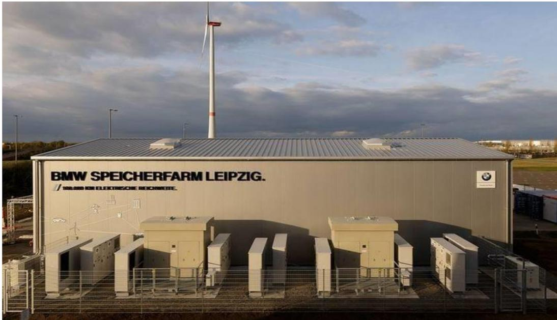
*Imagen 6.6: Instalación que agrupa la energía eólica y el almacenamiento a gran escala de la empresa BMW. Referencia [Freenet, 2019]*
