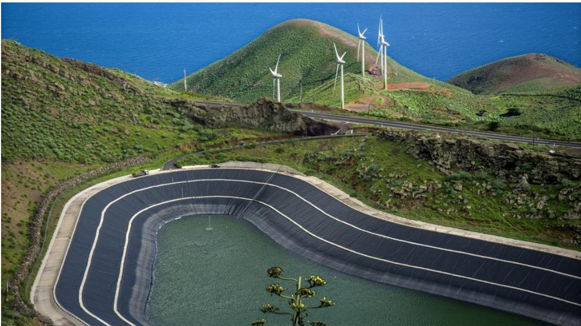
*Imagen 6.3: Depósito superior y parque eólico de la central hidroeólica en la isla de El Hierro. Referencia [Vanguardia, 2019]*
